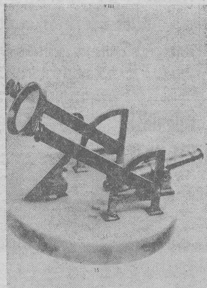
Reloj de cañón meridiano. Señala el mediodía con un cañonazo producido por el calor del sol sobre la lente. — (Foto Saphan Press)
