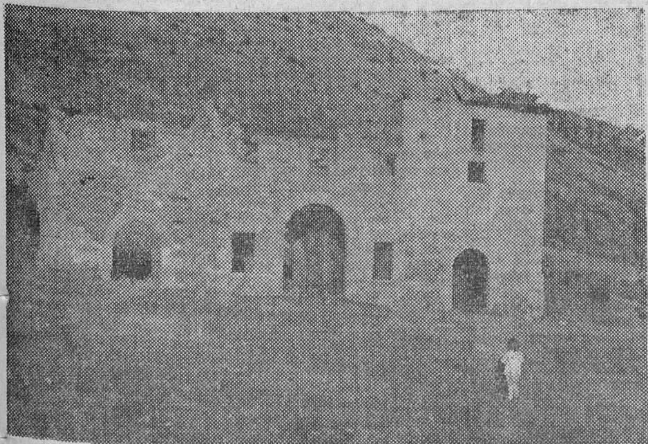
Uno de los tres grandes almacenes; en la parte superior habitación de la guardia.
