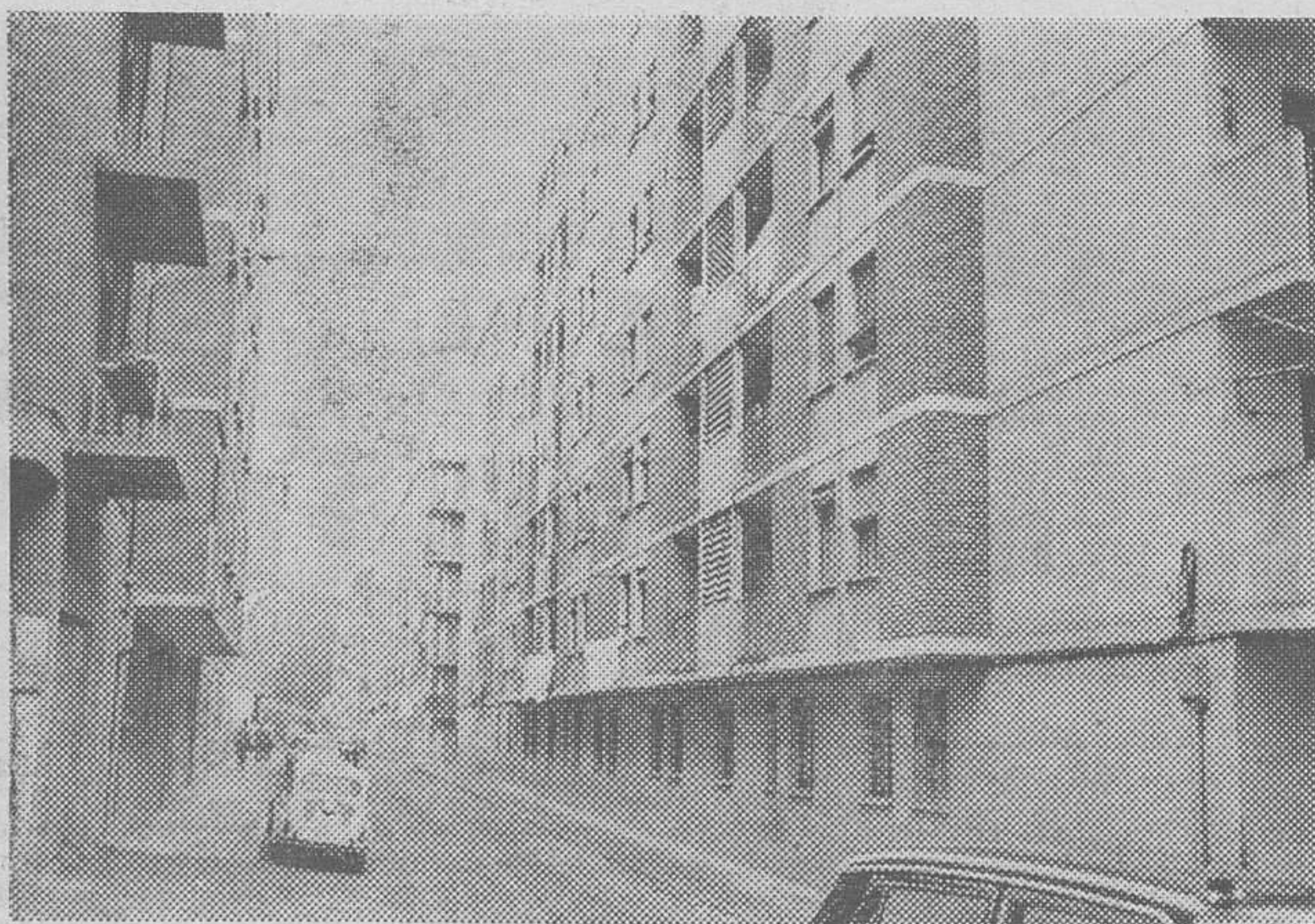
El barrio de San Francisco en las laderas del cerro de San Miguel, es uno de los que ha experimentado una mayor transformación urbana, claro ejemplo de las nuevas necesidades que en pavimentación y servicios demanda el crecimiento de la ciudad en sus calles. — (Foto FEDE)
