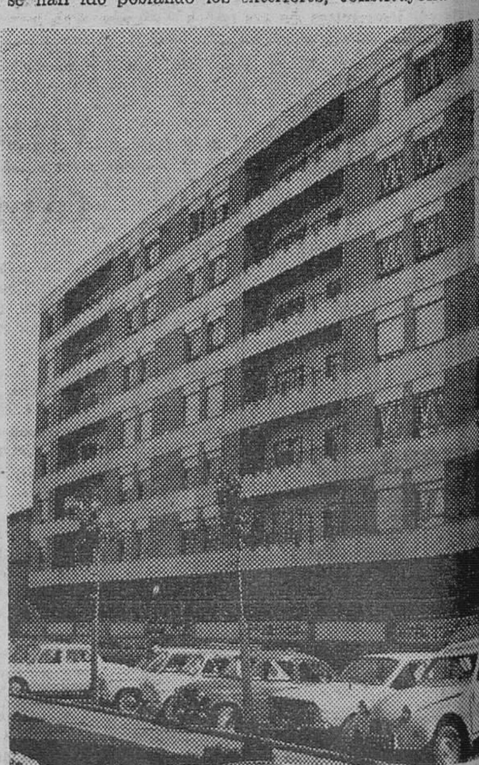
Fachada de un moderno edificio en construcción la Plaza de Primo de Rivera.—(Foto Díaz)
