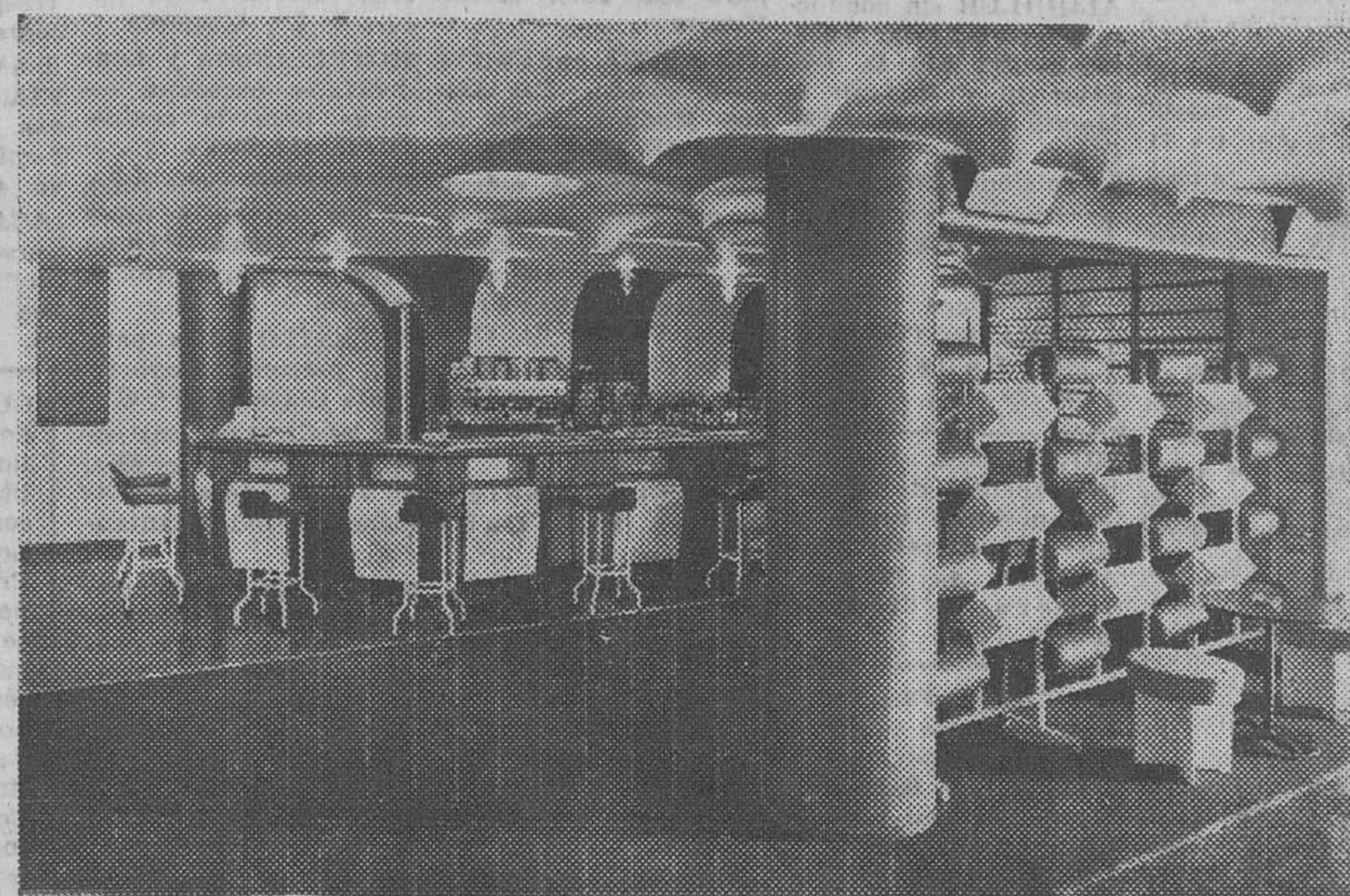
CAFETERIA-CLUB «MONTECARLO», Carretera Cortes.
