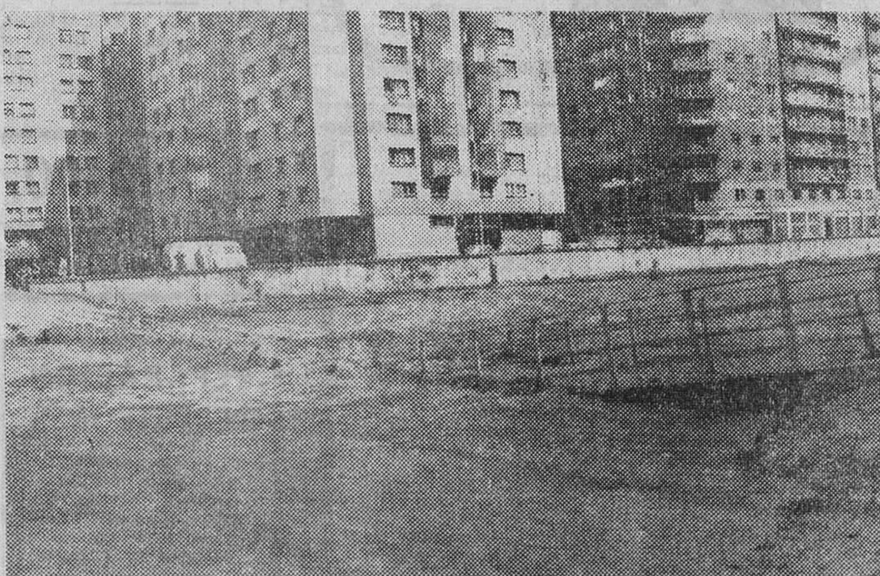
La crecida experimentada por nuestros ríos a consecuencia de las persistentes lluvias dio origen en la mañana de ayer a que la pasarela construida sobre el Arlanzon entre el paseo de la Quinta y la calle de Santa Casilda, quedara hundida y destruida por efecto de la impetuosa caída de las aguas, como nos muestra el grabado. — (Foto FEDE)
