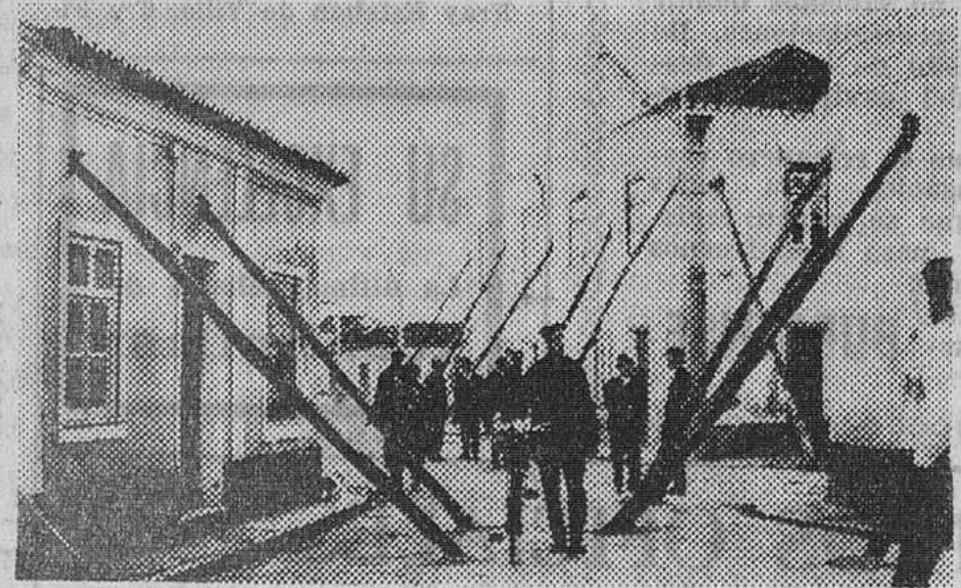
Portimao (Portugal). — Edificios apuntalados a causa de los efectos del temblor de tierra que se dejó sentir en la madrugada del pasado día 28. Esta localidad pertenece a la región del Algarve, al Sur de Portugal. — (Telefoto UPI-Cifra)
