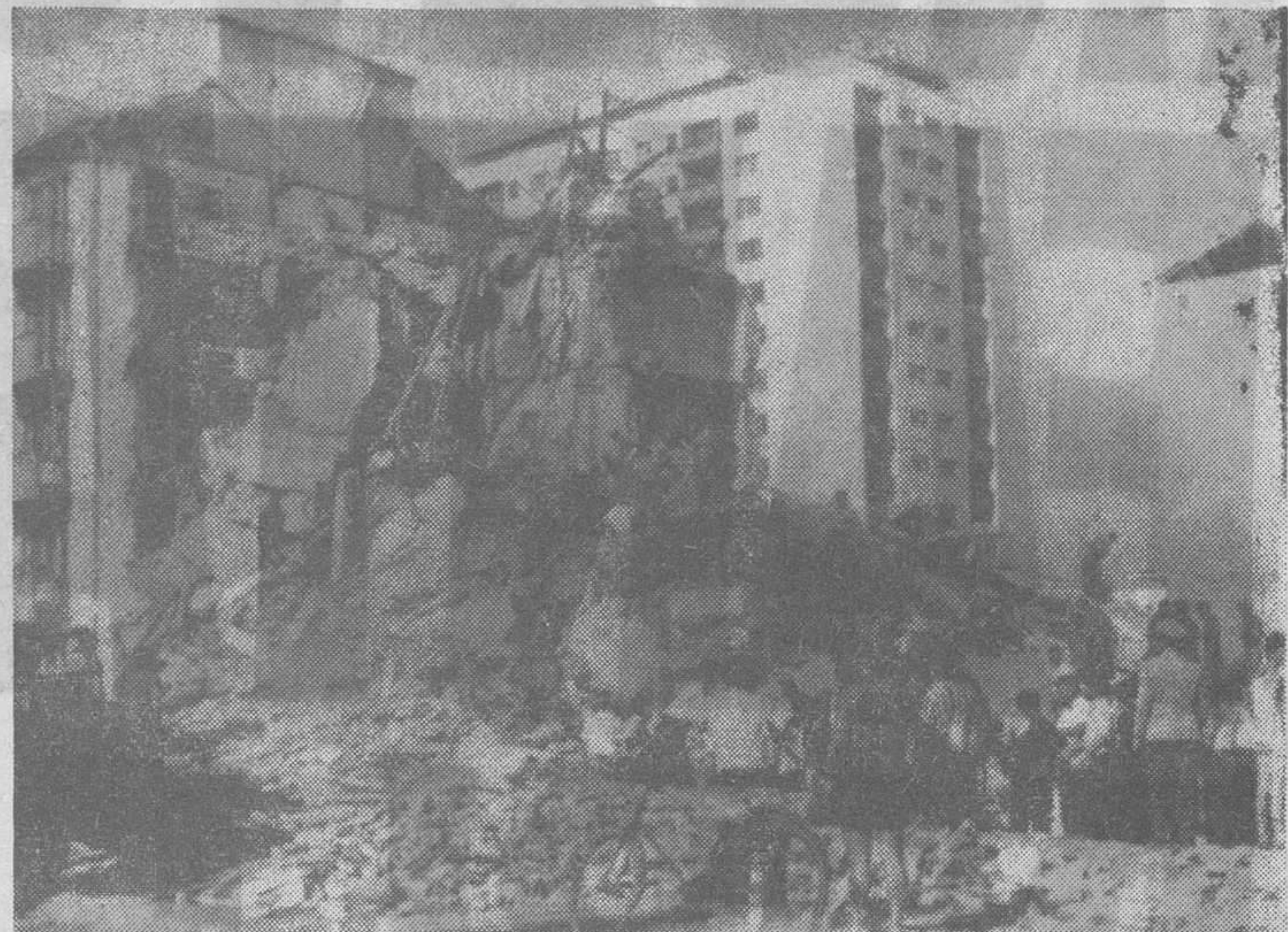
Uno de los terremotos que más víctimas y daños ha causado fue el de Skopje, en Yugoslavia. Vemos en la foto uno de los edificios abatidos por el movimiento sísmico. — (Foto Fiel)
