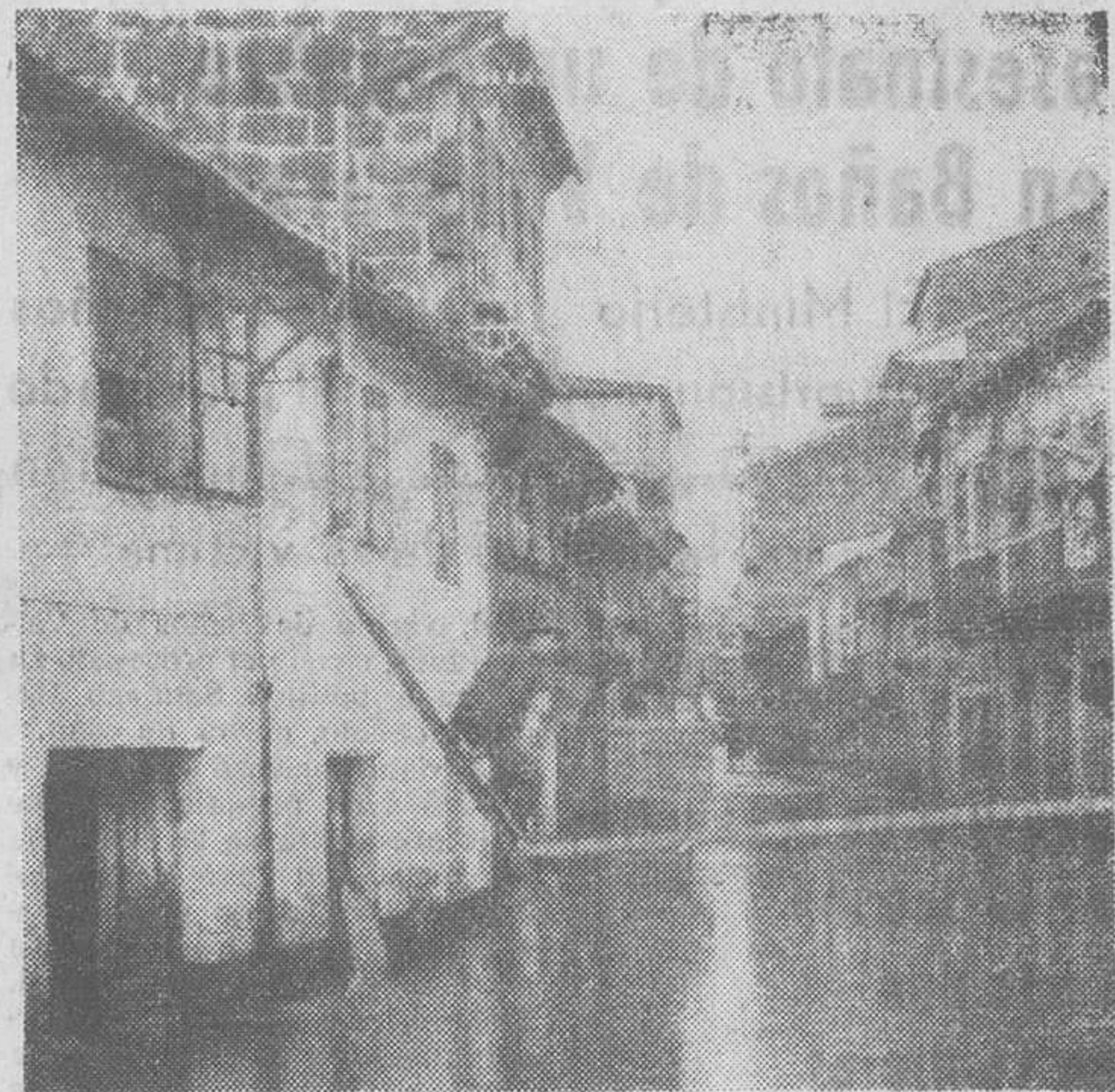
Verin (Orense).— El temporal de lluvias que viene azotando a toda España ha ocasionado gravísimas pérdidas en la provincia de Orense. Pueblos anegados, valles sumergidos bajo las aguas, tierras de labor arrasadas... He aquí un aspecto de la inundación sufrida por la villa de Verin, limitrofe con Portugal. La mayoría de las casas han sido desalojadas y para comunicarse entre ellas ha habido que improvisar rudimentarios puentes con escaleras tendidas de casa a casa. — (Foto Fiel).
