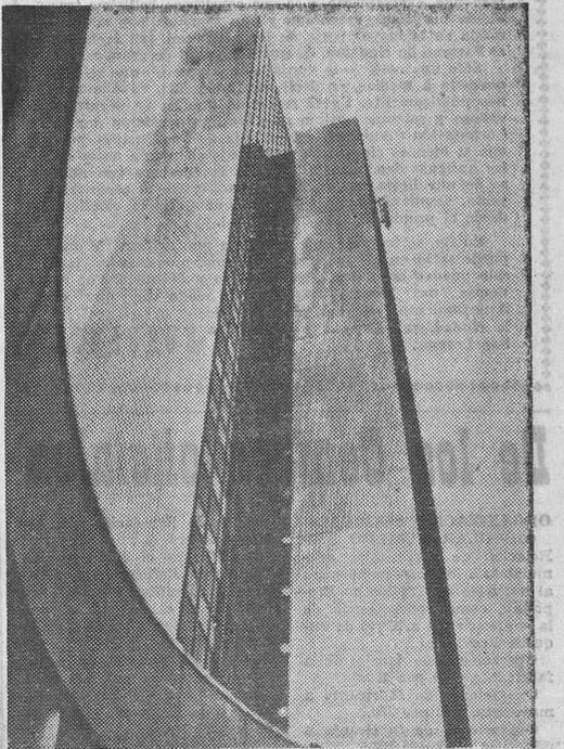
En Düsseldorf (Alemania) se levanta la impresionante estructura, de noventa y cinco metros de altura de la casa de Thyssen. Sus veinticuatro pisos están contruidos de acero, aluminio y cristal. El acero reviste los costados del edificio y tubos, de acero también, han sido empleados como pilares. Con estas edificaciones los urbanistas alemanes ven una posibilidad de edificar en las grandes ciudades, ante la escasez de terreno. — (Foto Fiel)
