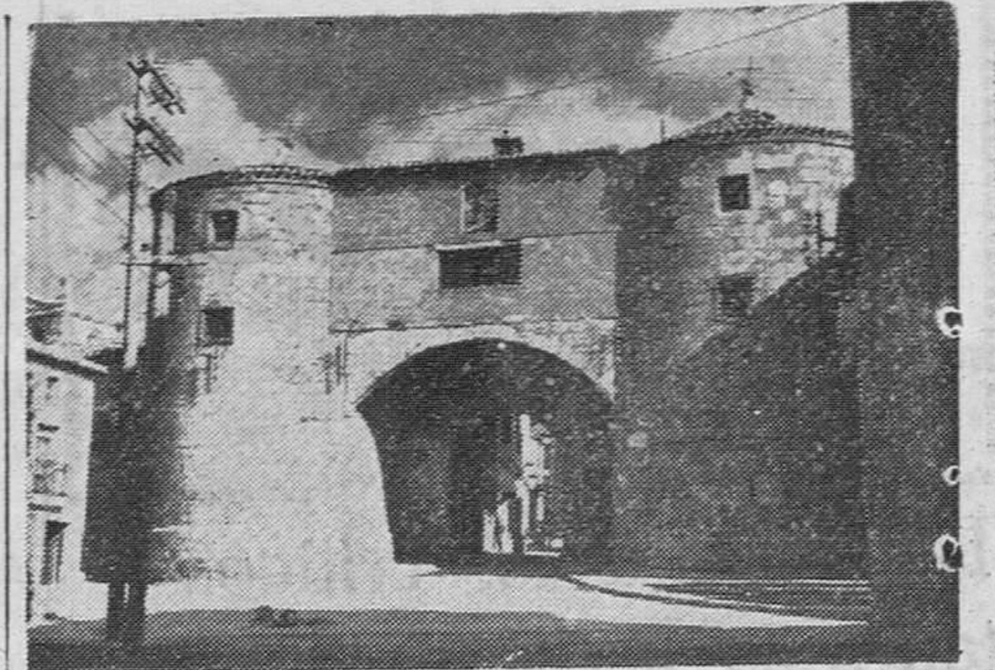
ARCO DE ENTRADA A LA VILLA
