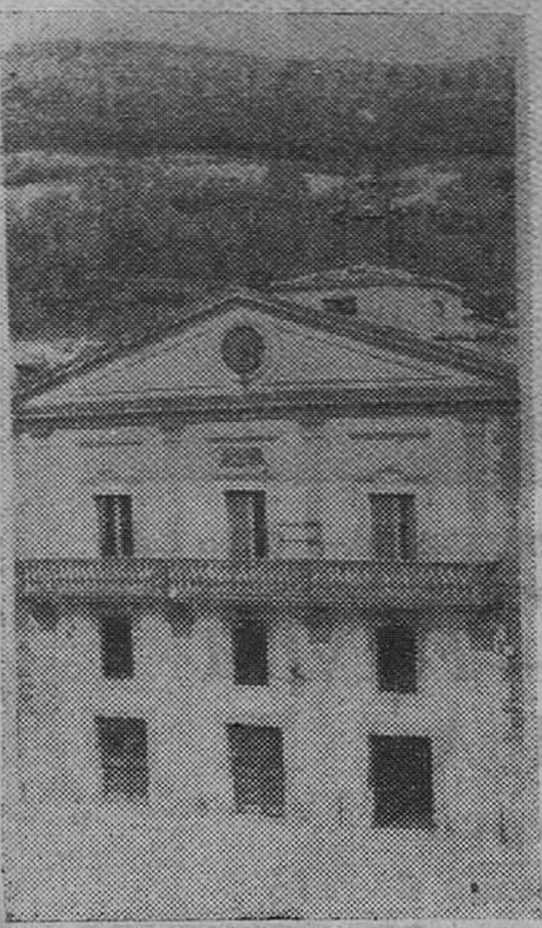
EDIFICIO DEL AYUNTAMIENTO
