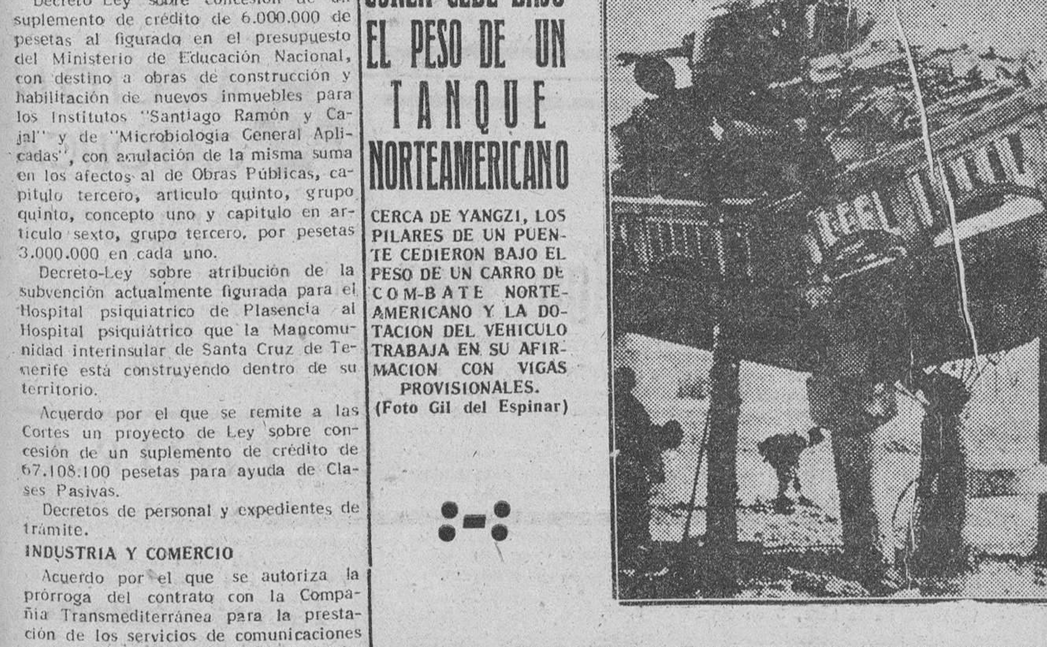
CERCA DE YANGZI, LOS PILARES DE UN PUNTO CEDIERON BAJO EL PESO DE UN CARRO DE COMBATE NORTEAMERICANO Y LA DOTACION DEL VEHICULO TRABAJA EN SU AFIRMACION CON VIGAS PROVISIONALES. (Foto Gil del Espinar)
