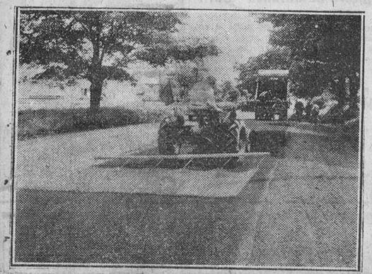
Washington.— En los Estados Unidos ha empezado a ensayarse un nuevo pavimento para carreteras a base de caucho pulverizado y arena, que se aplica sobre el asfalto y evita patinazos. En la fotografía se ve un aspecto de la aplicación del nuevo pavimento.
