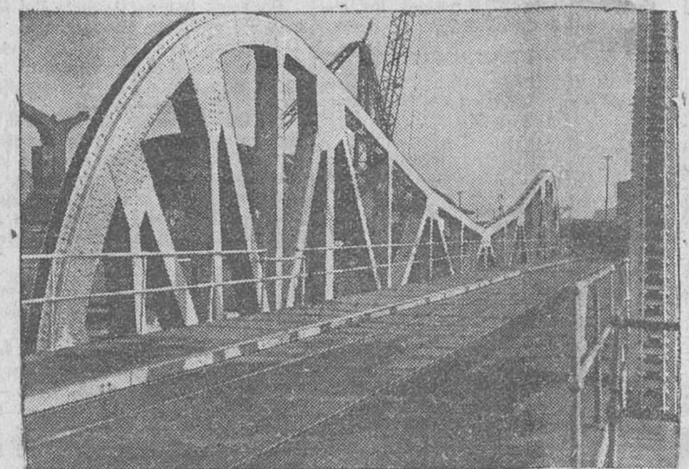
Londres. -- He aquí el primer puente de aluminio construido en el Mundo. Su coste ha sido de 85.000 libras esterlinas. No pesa más de 54 toneladas y tiene una longitud de 2750 metros. Admite tráfico ferroviario y carretera. -- (Foto CALPE)
