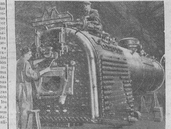
La industria ferroviaria inglesa se dedica activamente a la construcción de locomotoras para sustituir a las numerosas que resultaron destruidas durante la guerra. Estos obreros ajustan las últimas piezas en la sección de calderas de una nueva máquina que pronto será puesta en servicio.
