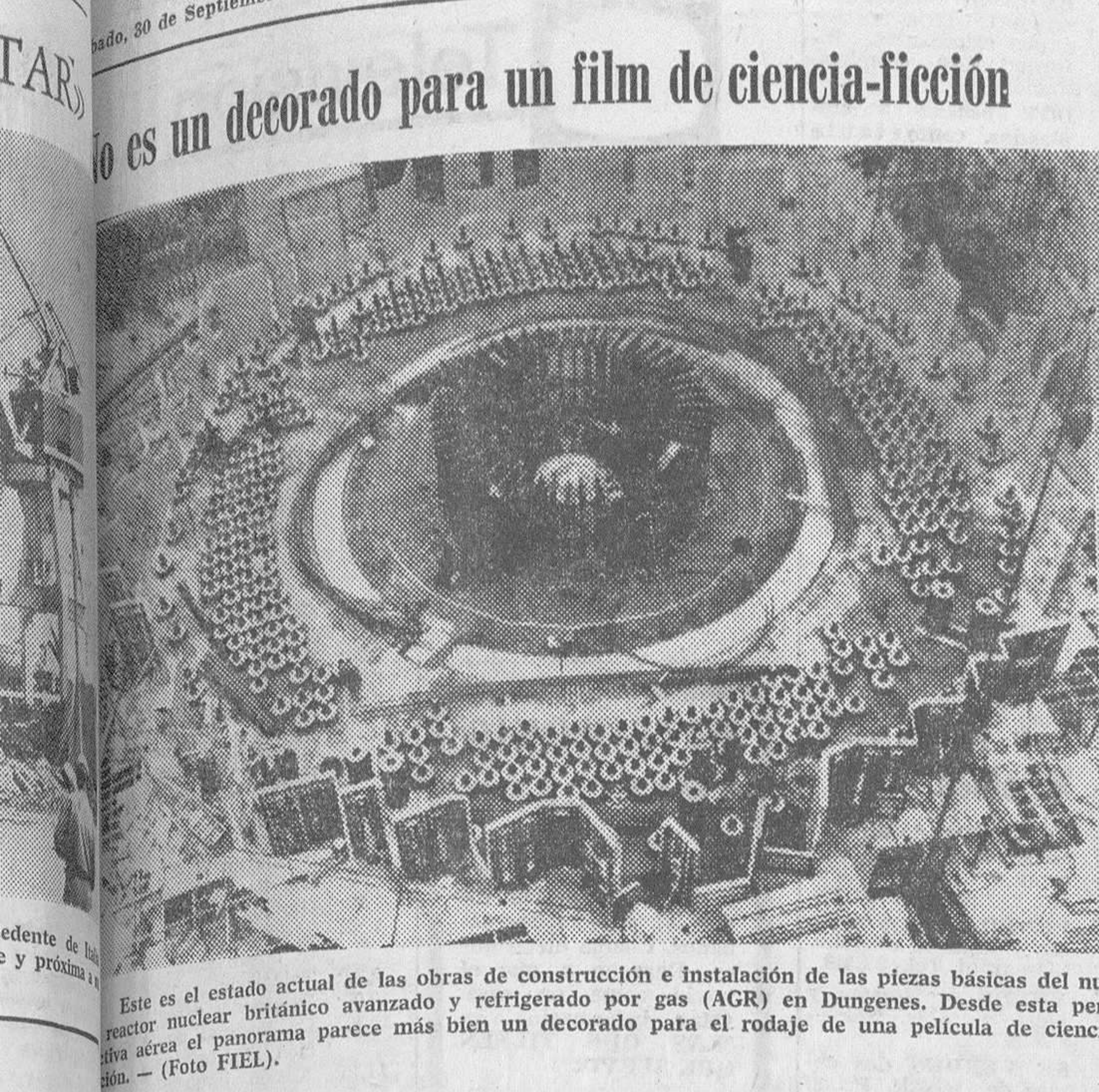
Este es el estado actual de las obras de construcción e instalación de las piezas básicas del reactor nuclear británico avanzado y refrigerado por gas (AGR) en Dungenes. Desde esta perspectiva aérea el panorama parece más bien un decorado para el rodaje de una película de ciencia-ficción. — (Foto FIEL).
