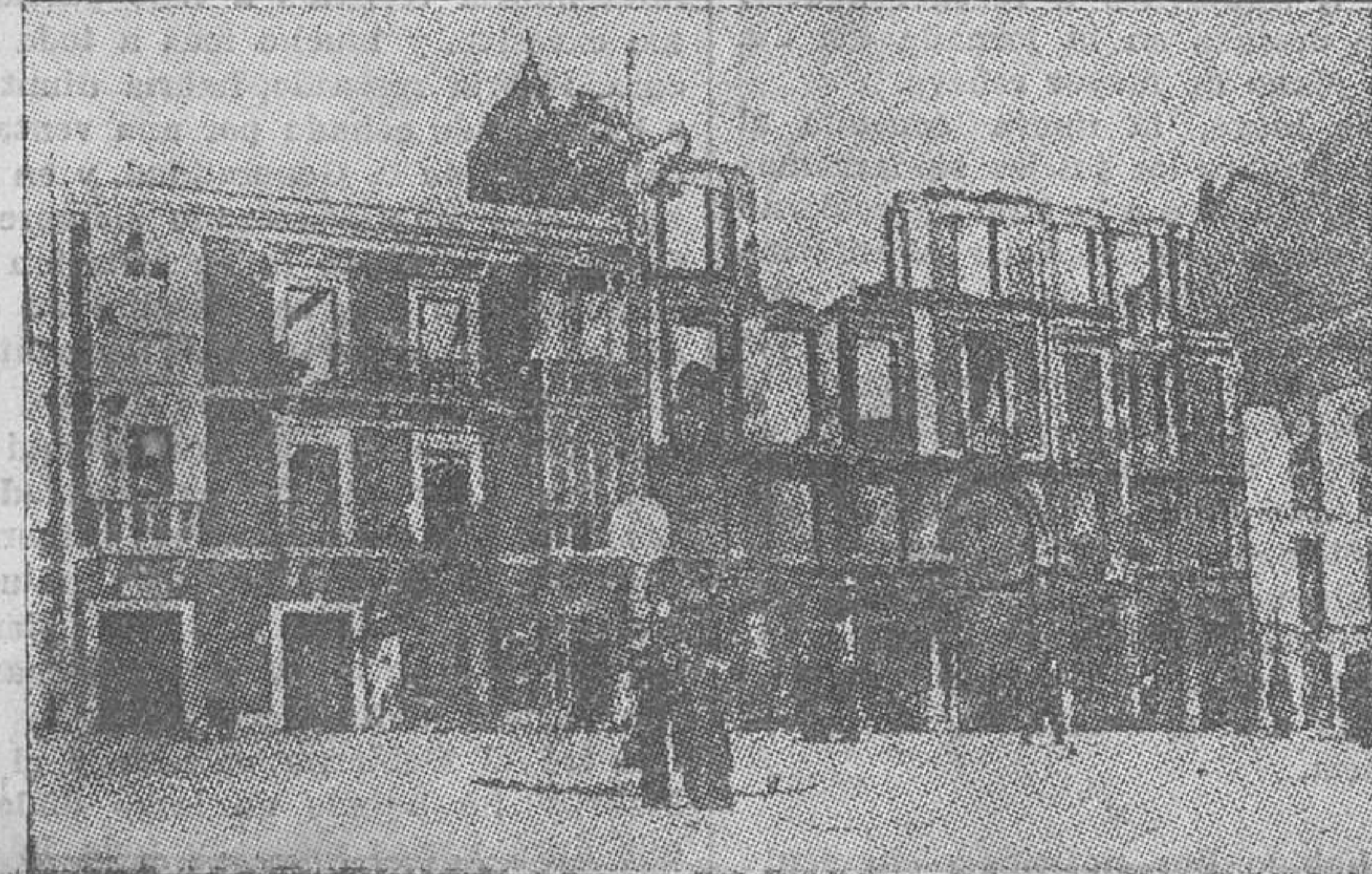
DEL PASADO MOVIMIENTO REVOLUCIONARIO EN ASTURIAS. — Arriba, lo que queda de la Universidad. En el patio, inóclume, la estatua de Valdés y Salas. — Más abajo, lo que queda del Instituto de Oviedo, edificio moderno, de construcción reciente, destruido por la voladura del polvorín en que estuvo convertido por los revoltosos. — Y el grupo de edificios de la calle de Argüelles, de Oviedo, correspondientes a una de las manzanas de casas céntricas, más castigadas por el fuego y la metralla. (Foto Klark.)
