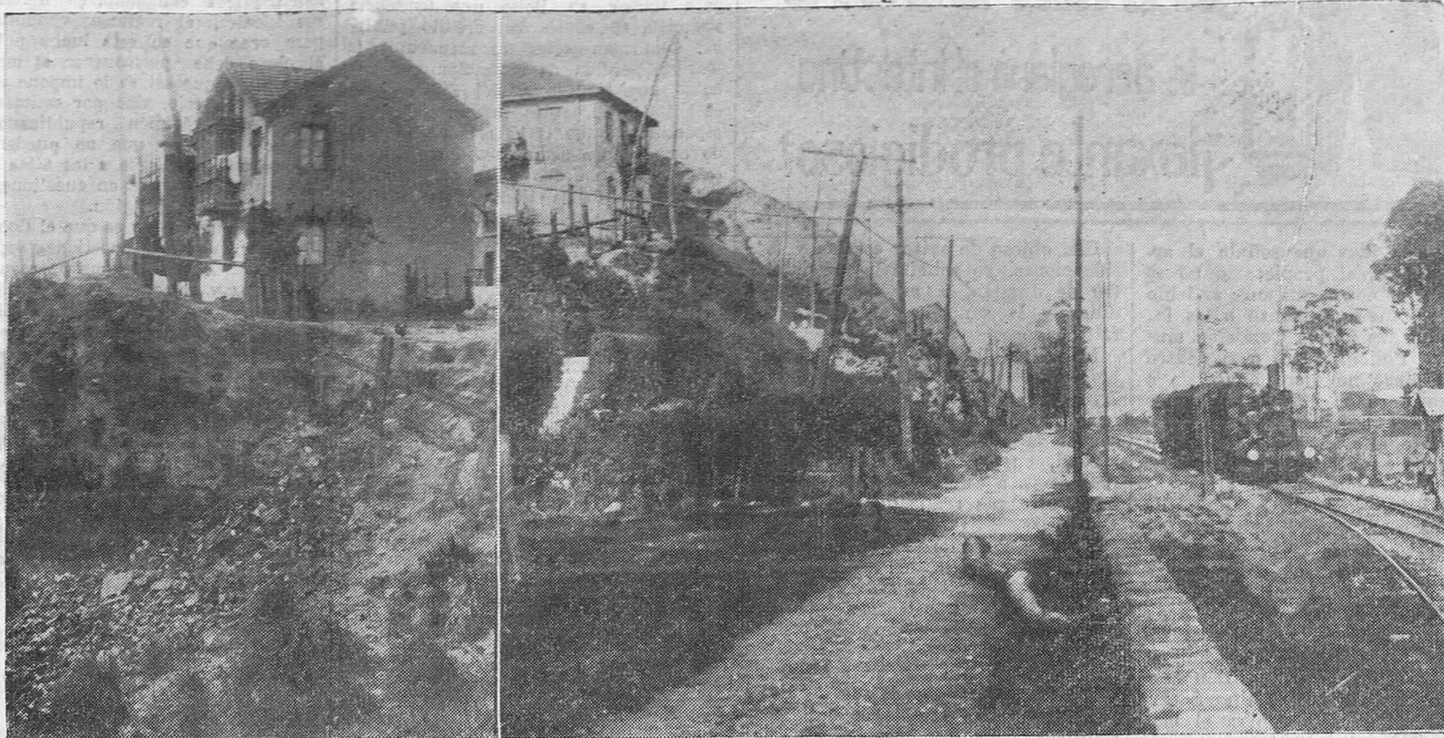
Las casas de la Peña del Cuervo, cuyas aguas sucias se vierten al exterior en forma peligrosa para la salud, y cuyo hecho ha sido denunciado por el concejal señor Vayas. — La calle que es necesario construir en esa parte de la ciudad. (Fotos Samol.)
