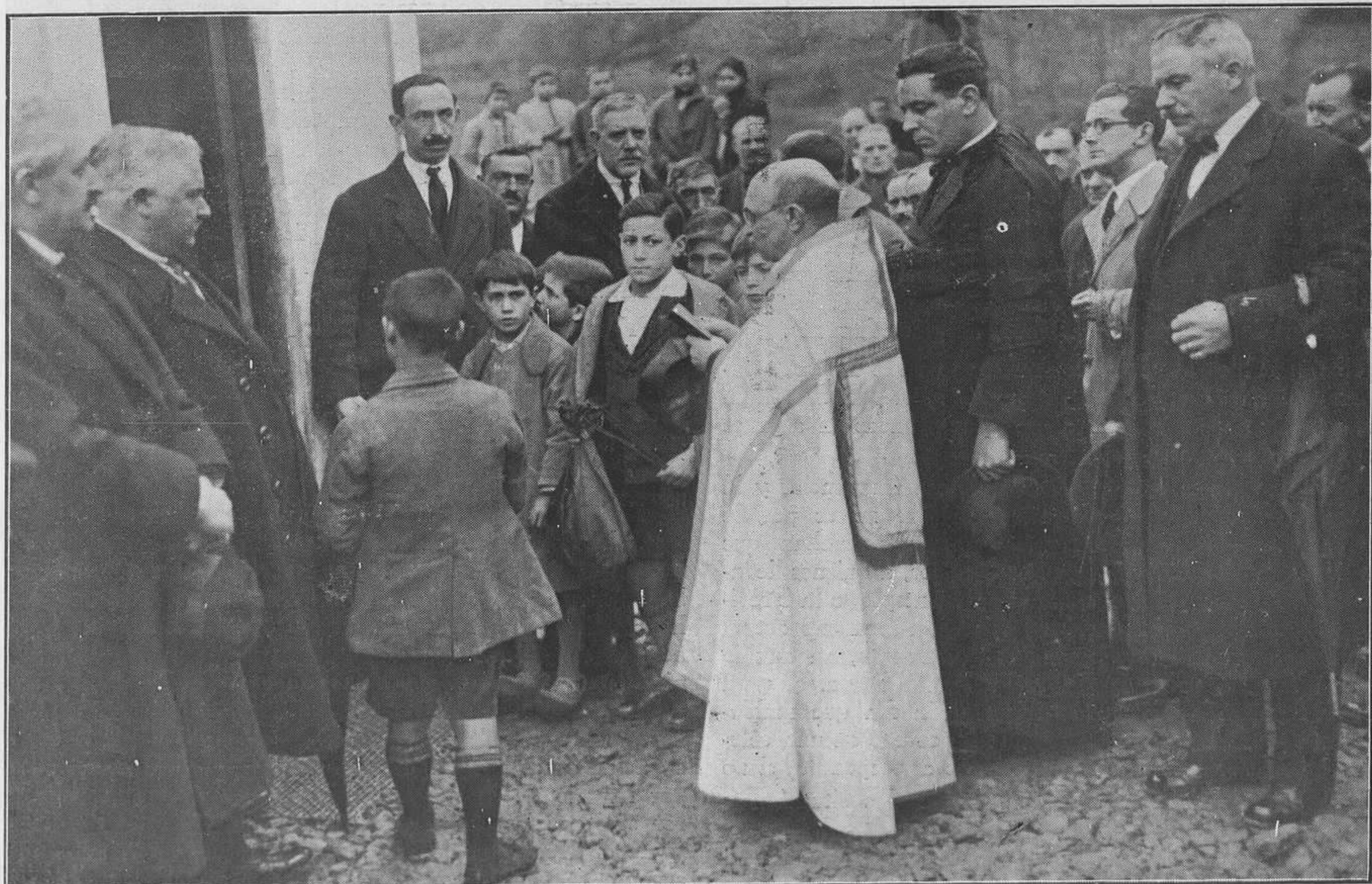
AMPUERO.—Momento de ser bendecida, por el párroco señor Terradillos, la nueva traída de aguas, obra que en aquella localidad supone un paso decisivo hacia el progreso y hacia el adelanto. (Foto. Samot.)
