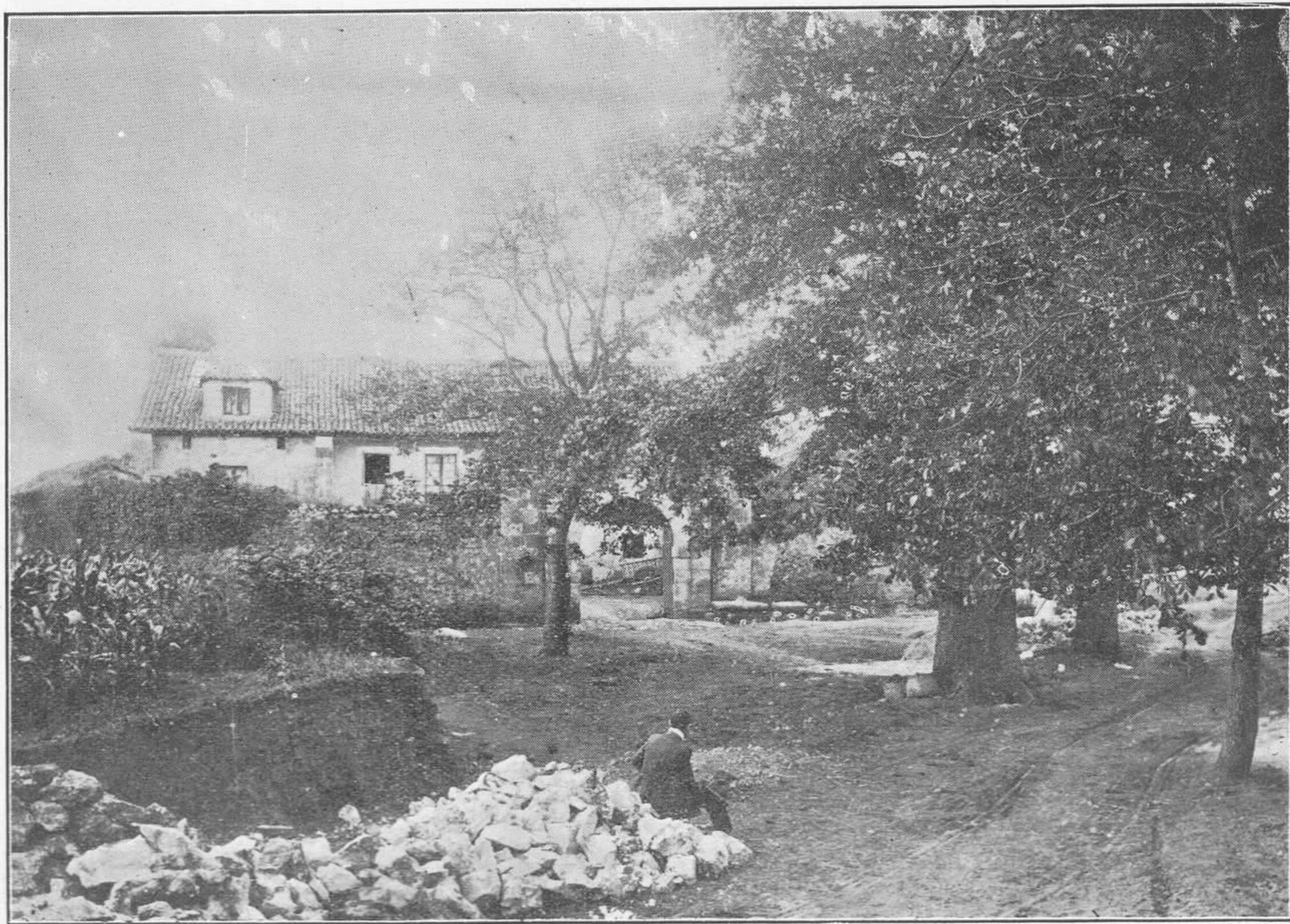
REVILLA DE CAMARGO.—Pintoresca vista de una casa solariega.
