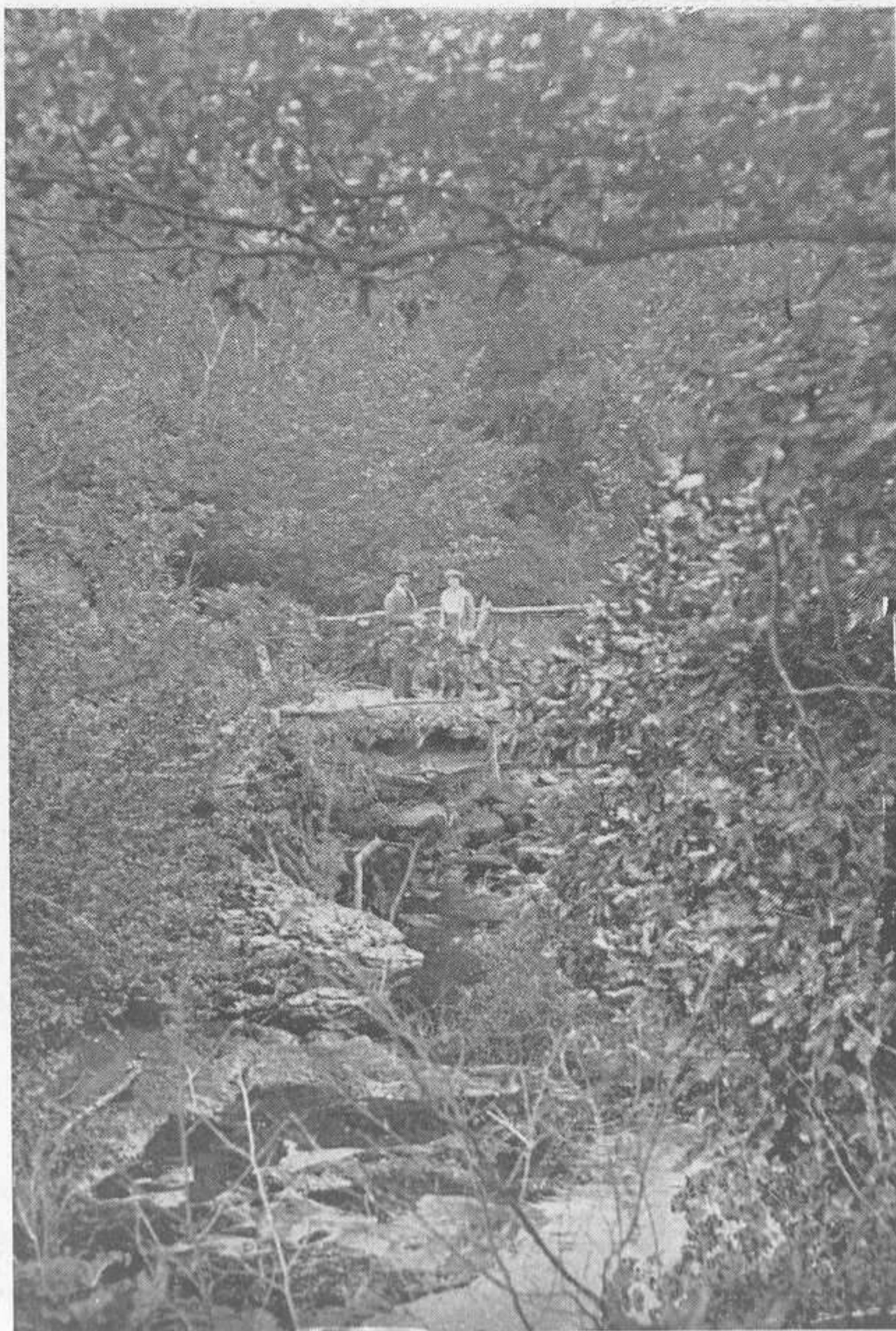
BARRUELO.—Hermosa vista del puente del Oso.
