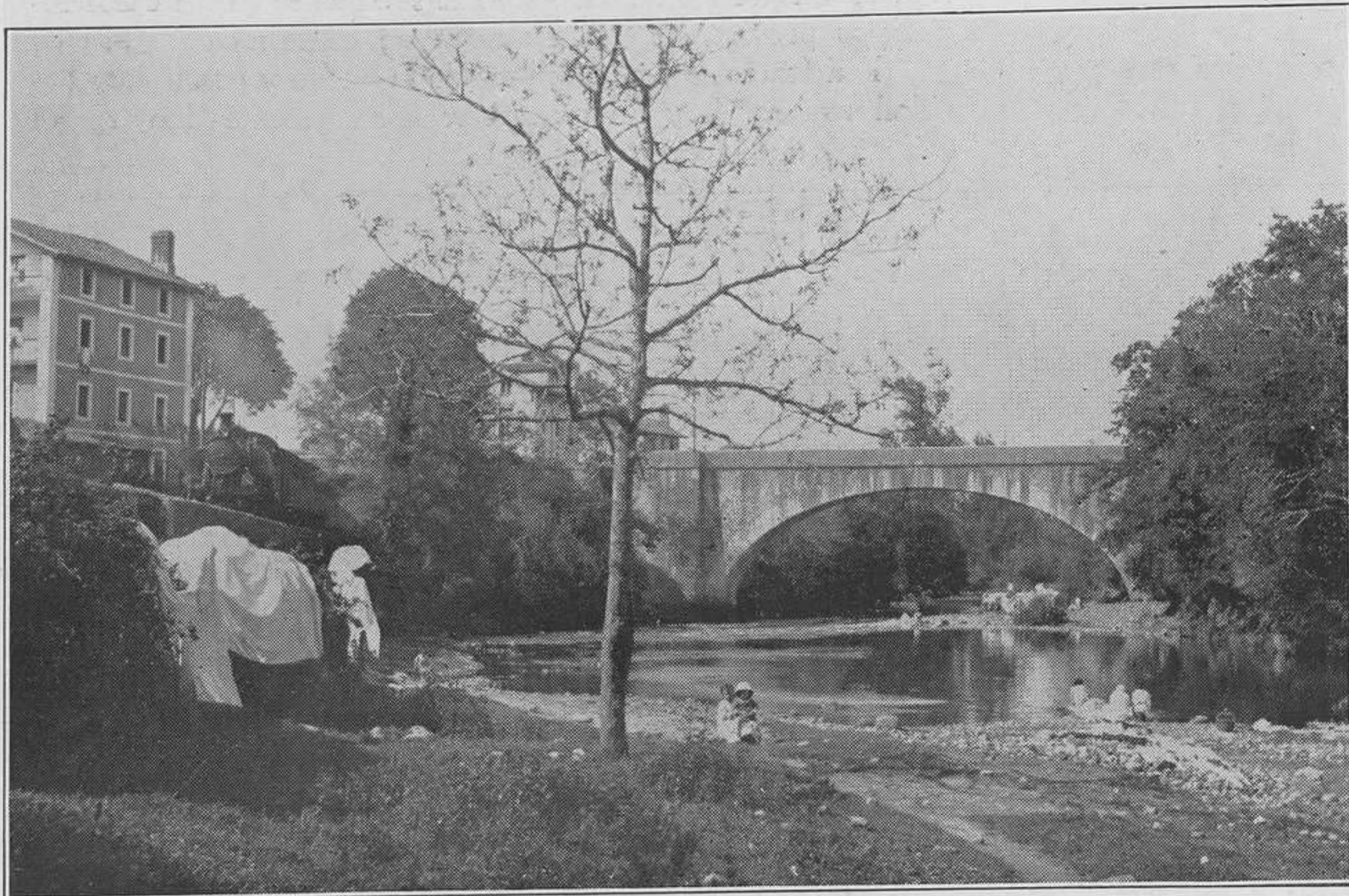
SOLARES. —Precioso paisaje en el que se destaca el soberbio puente sobre el río Miera, de 40 m. de luz y 20 de altura y cuyo intradós es una elegante curva carpanel de cinco centros. El conjunto de esta magnífica obra es siempre muy elogiado por los inteligentes.
