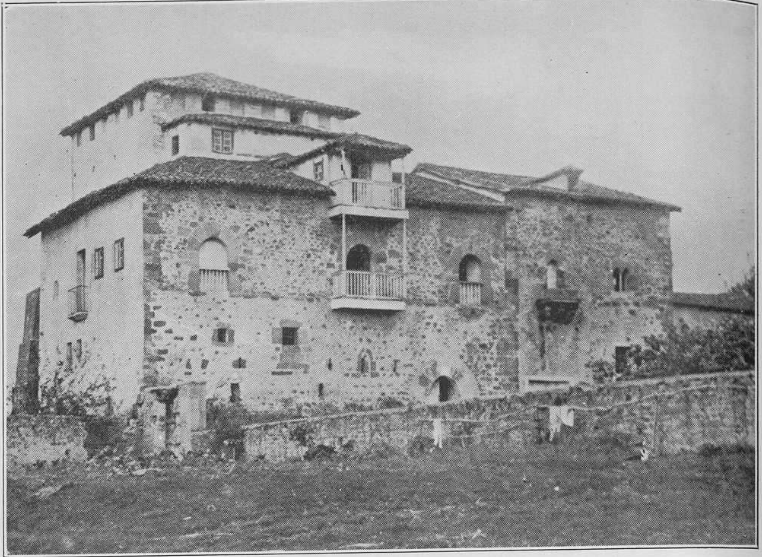
Casa Torre de Calderón de la Barca, estado actual
