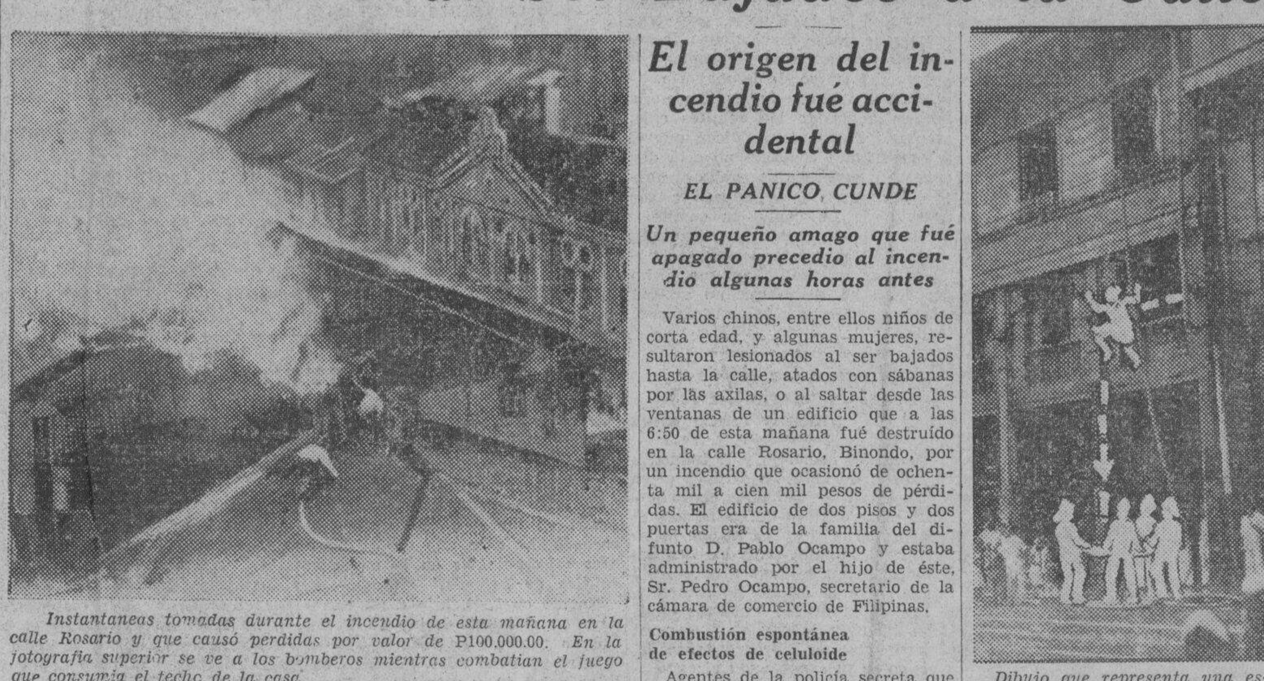
Instantaneos tomadas durante el incendio de esta mañana en la calle Rosario y que causó pérdidas por valor de P100,000.00. En la foto superior se ve a los bomberos mientras combatian el fuego que consumia el techo de la casa.
