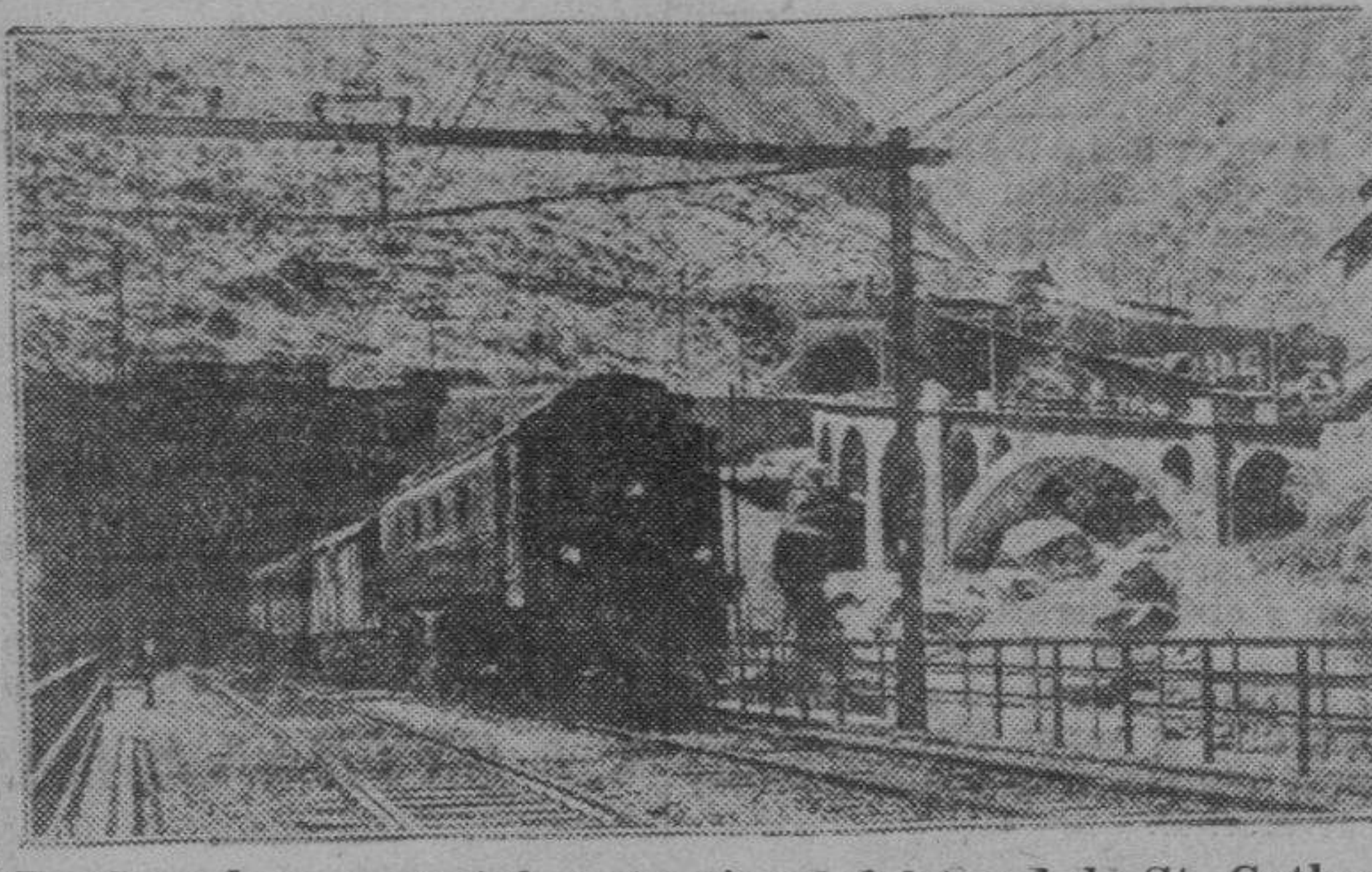
En Goeschenen, portal septentrional del tunel de St. Gothard
