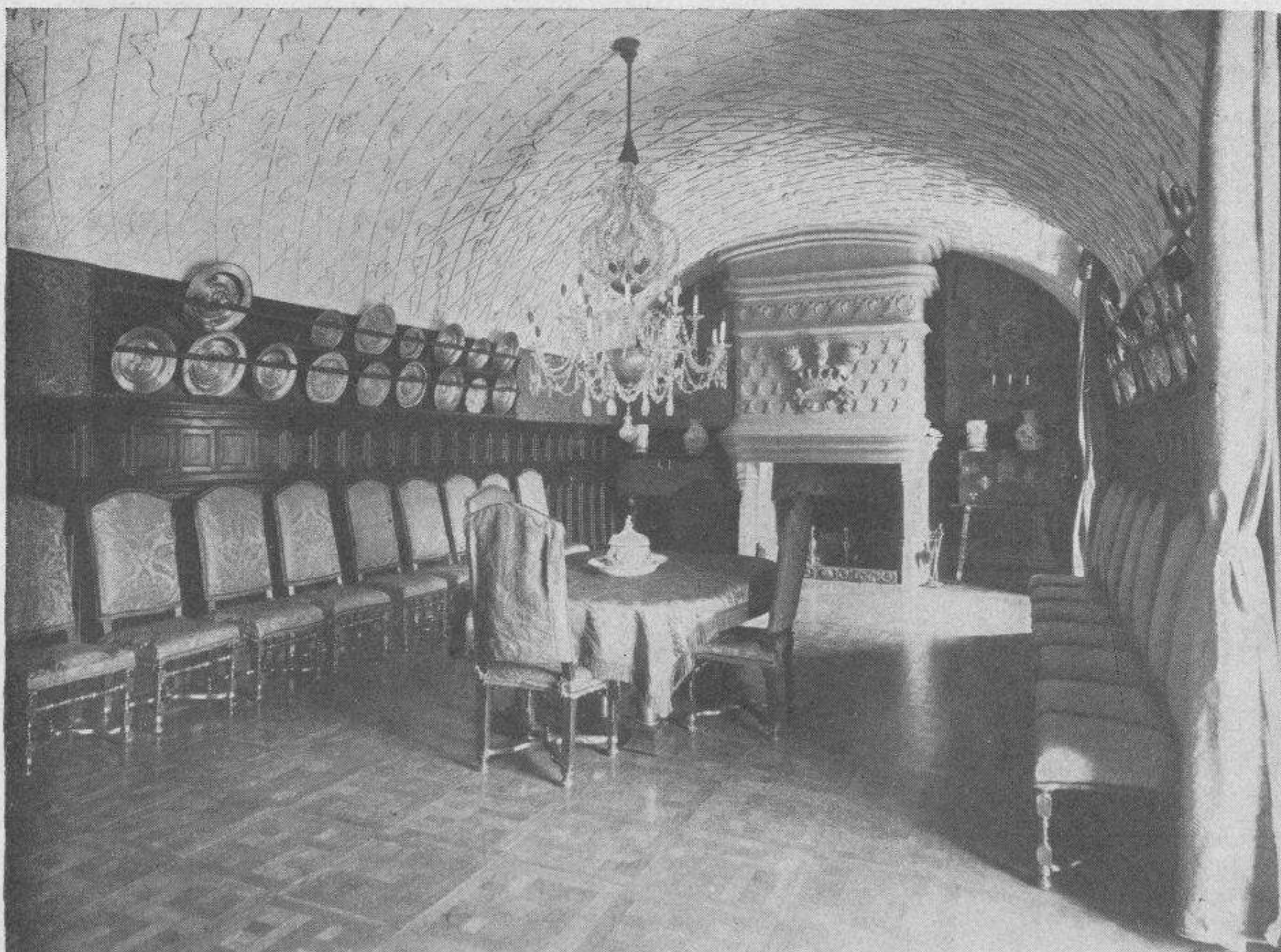
Comedor de la planta baja.
