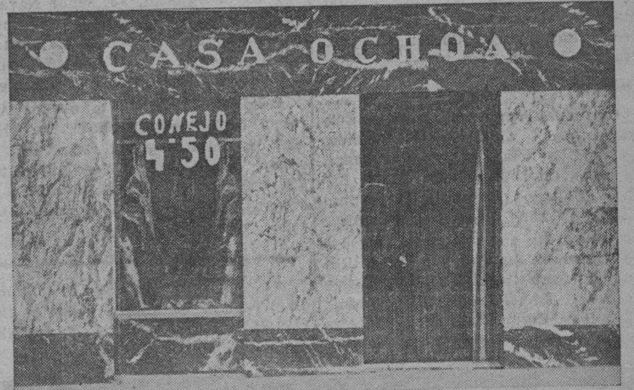
Portada recientemente reformada del magnífico establecimiento de carnicería de don Dionisio Ochoa
