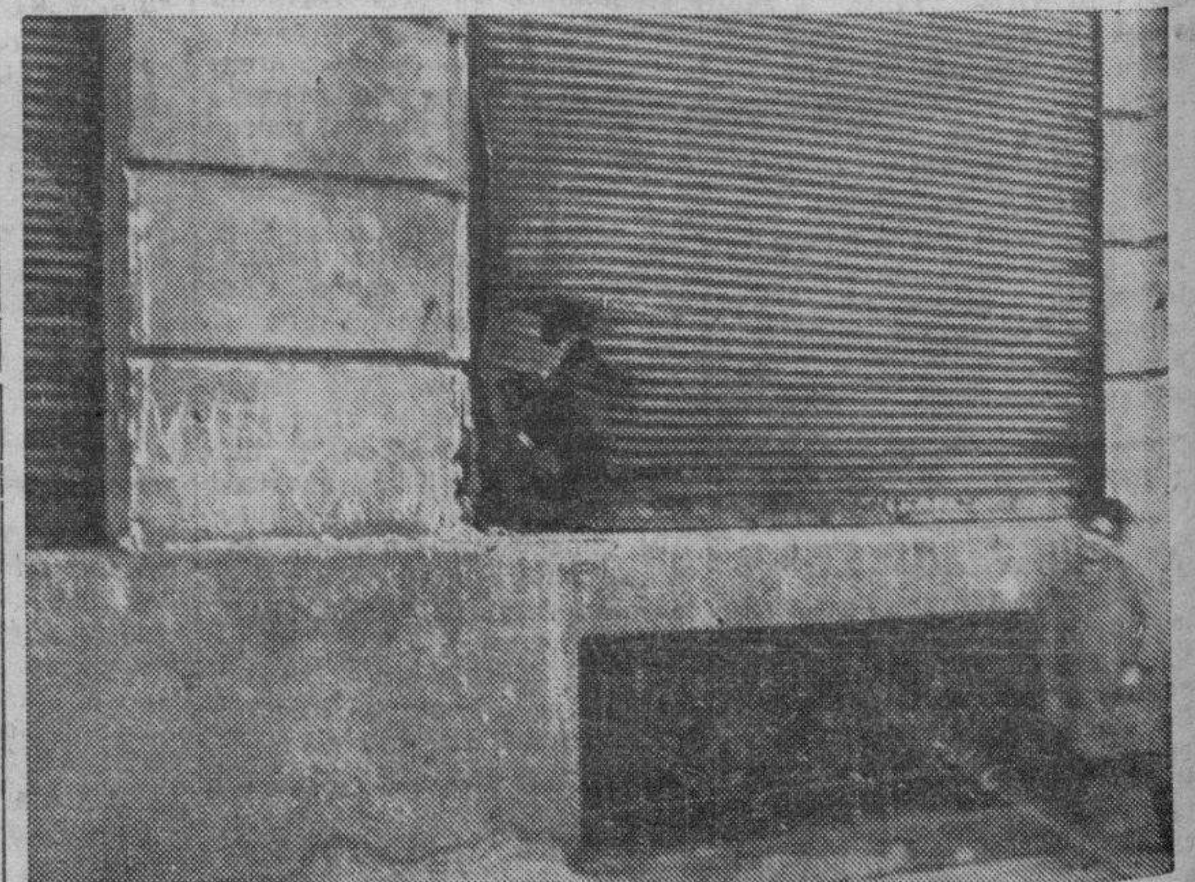
Desperfectos producidos en la fachada de la fábrica de camas del señor Soláns por la explosión de una bomba, ocurrida en la noche del día 25. (Foto. A. de la Barrera)
