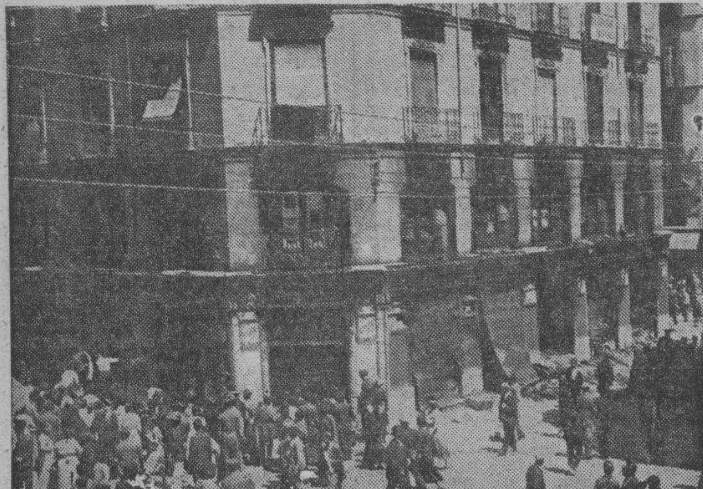
Aspecto que ofrecía la fachada de la Casa Polo, poco después de haber dado fin los trabajos de extinción.
