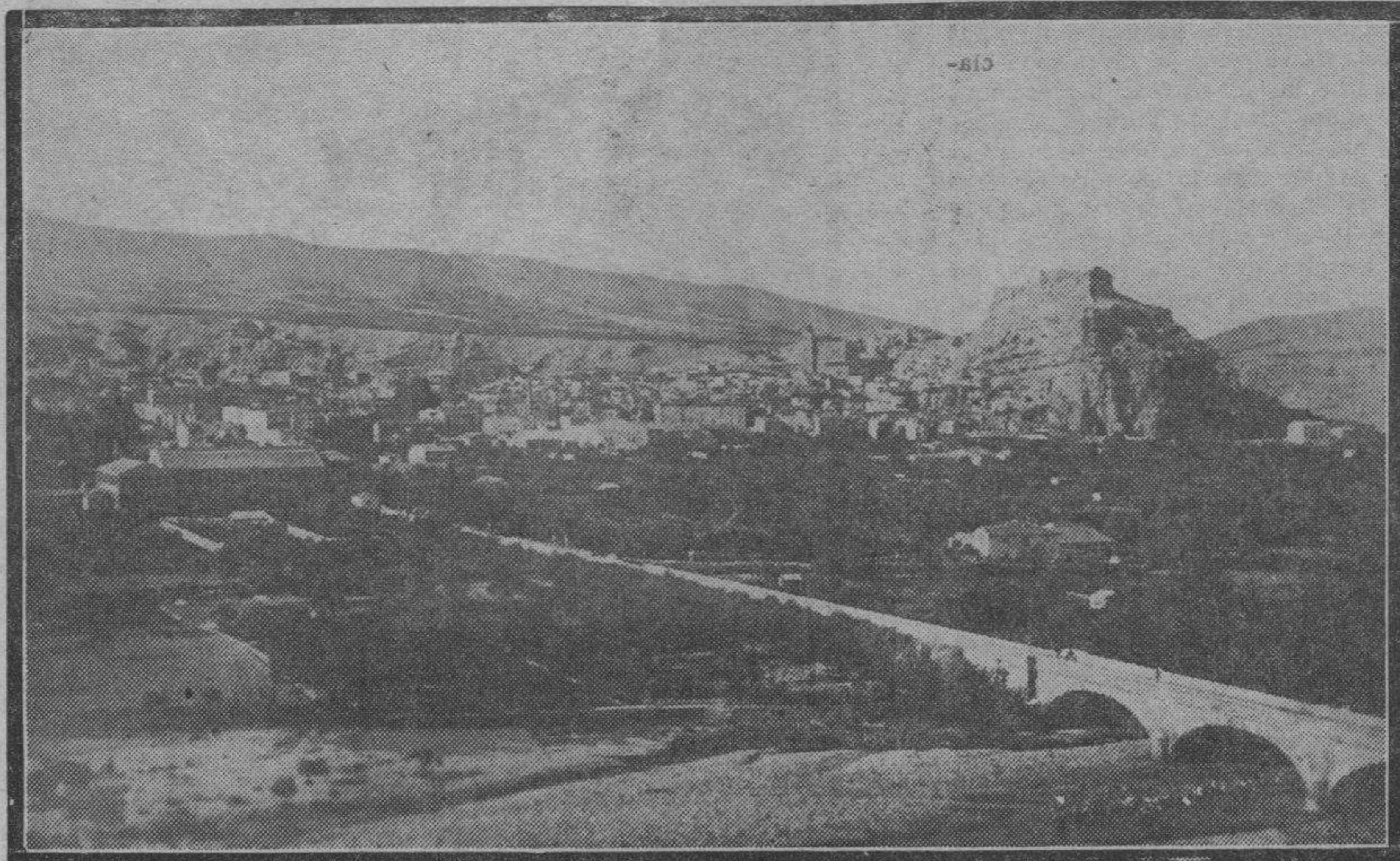
ARNEDO. — Vista general de la villa de Arnedo, y parcial de su hermosa vega.
