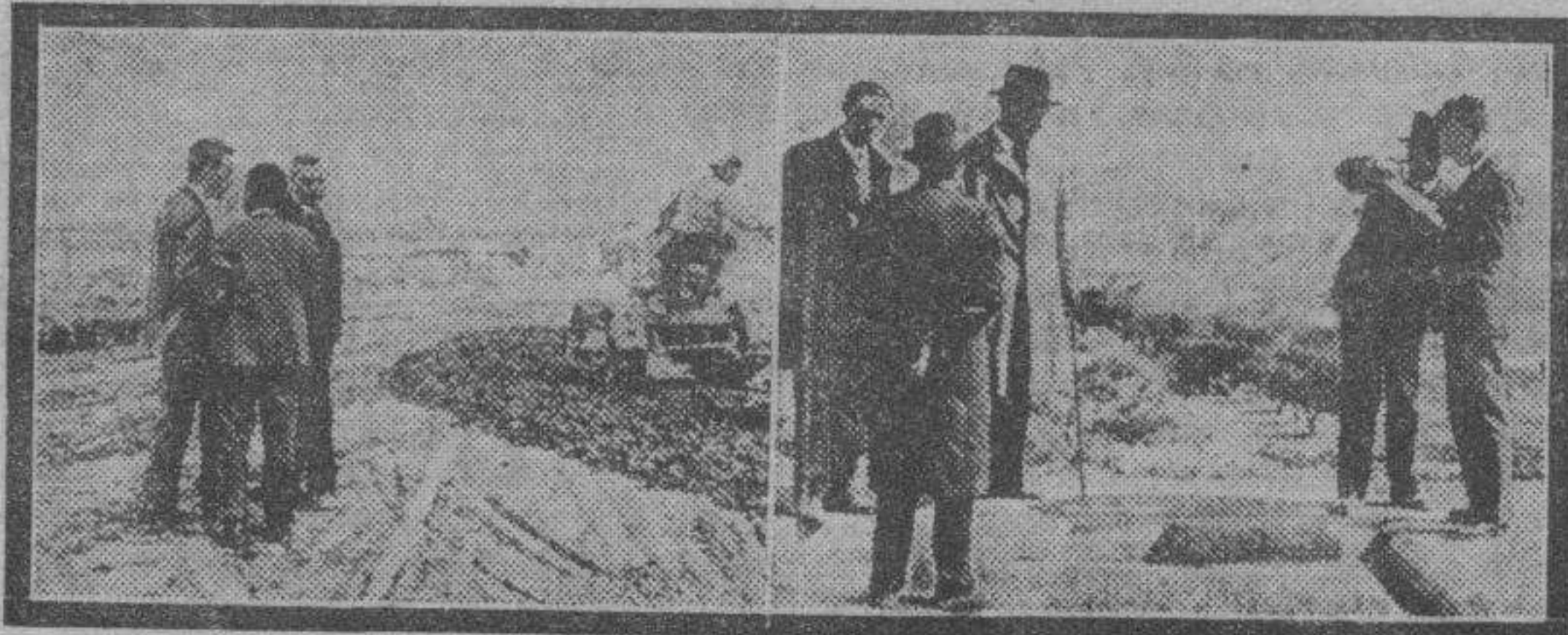
El director general de Obras Hidráulicas presencia la nivelación de tierras en La Melusa. — Sobre el sifón del Josa, en el Canal de Aragón y Cataluña, el director de la Mancomunidad del Ebro, don Félix de los Ríos, explica las características de la obra al director general de Obras Hidráulicas.
