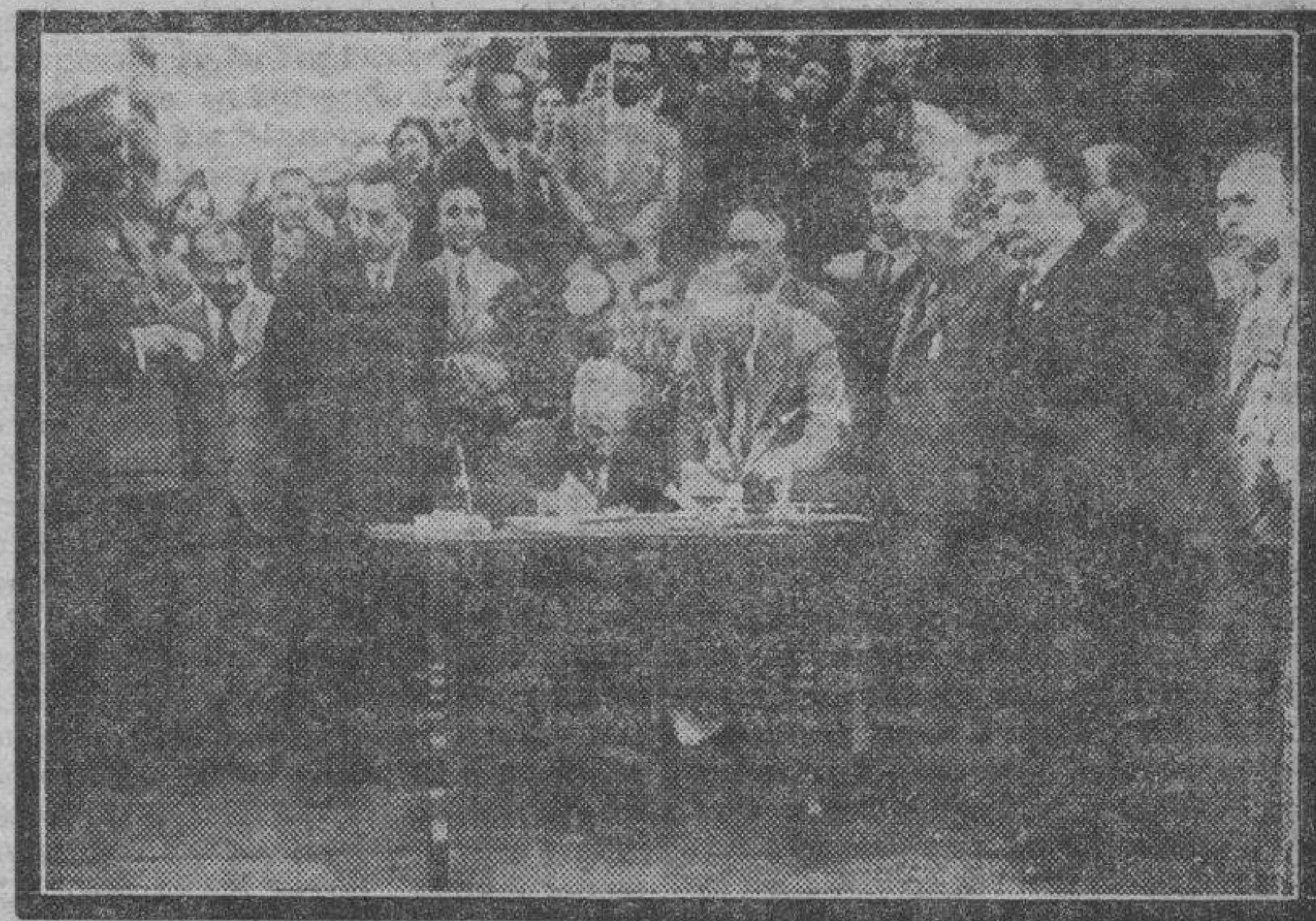
El presidente de la República en el histórico momento de firmar el acta de iniciación de obras en el lugar donde ha de estar enclavado el pantano de Ortigosa. Rodean al señor Alcalde Zamora el ministro de Obras Públicas, el de Estado y personas que ostentan altos cargos en la Mancomunidad del Ebro.
