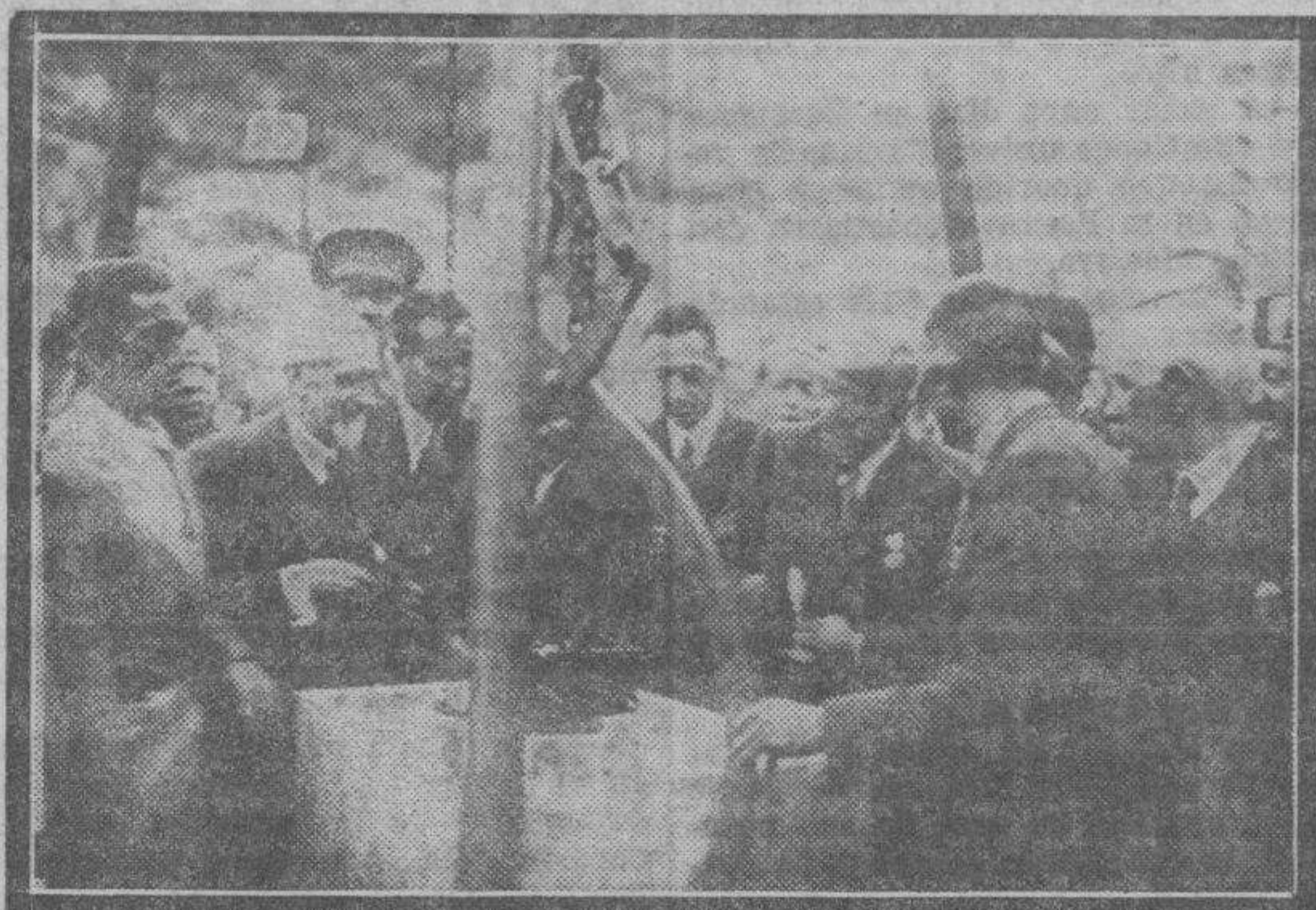
El jefe del Estado, ministros, personalidades del séquito, invitados y público, en la colocación de la primera piedra en el valle donde ha de construirse el pantano de Ortigosa, que tan grandes beneficios reportará a gran parte de la llanura riojana.
