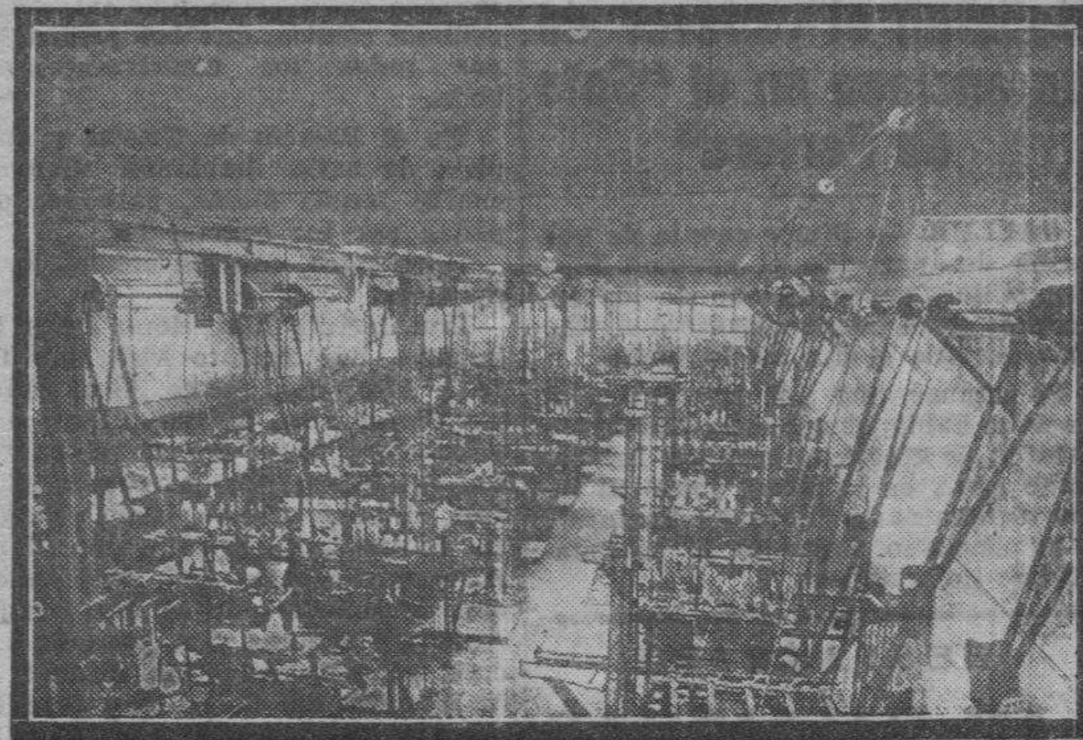
Un aspecto de la nave de telares rectilíneos y curvilíneos
