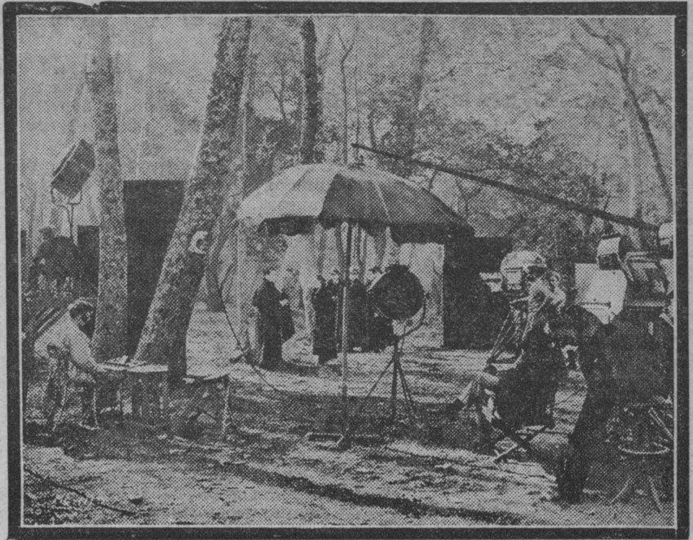
Cuando vemos esas escenas tan extraordinarias hechas a pleno día, nos asombra la perfección de las luces, y por tanto los efectos fotográficos. La cosa no tiene otro secreto que el saber colocar debidamente una formidable serie de reflectores, con los que se llega a dominar la luz solar.
