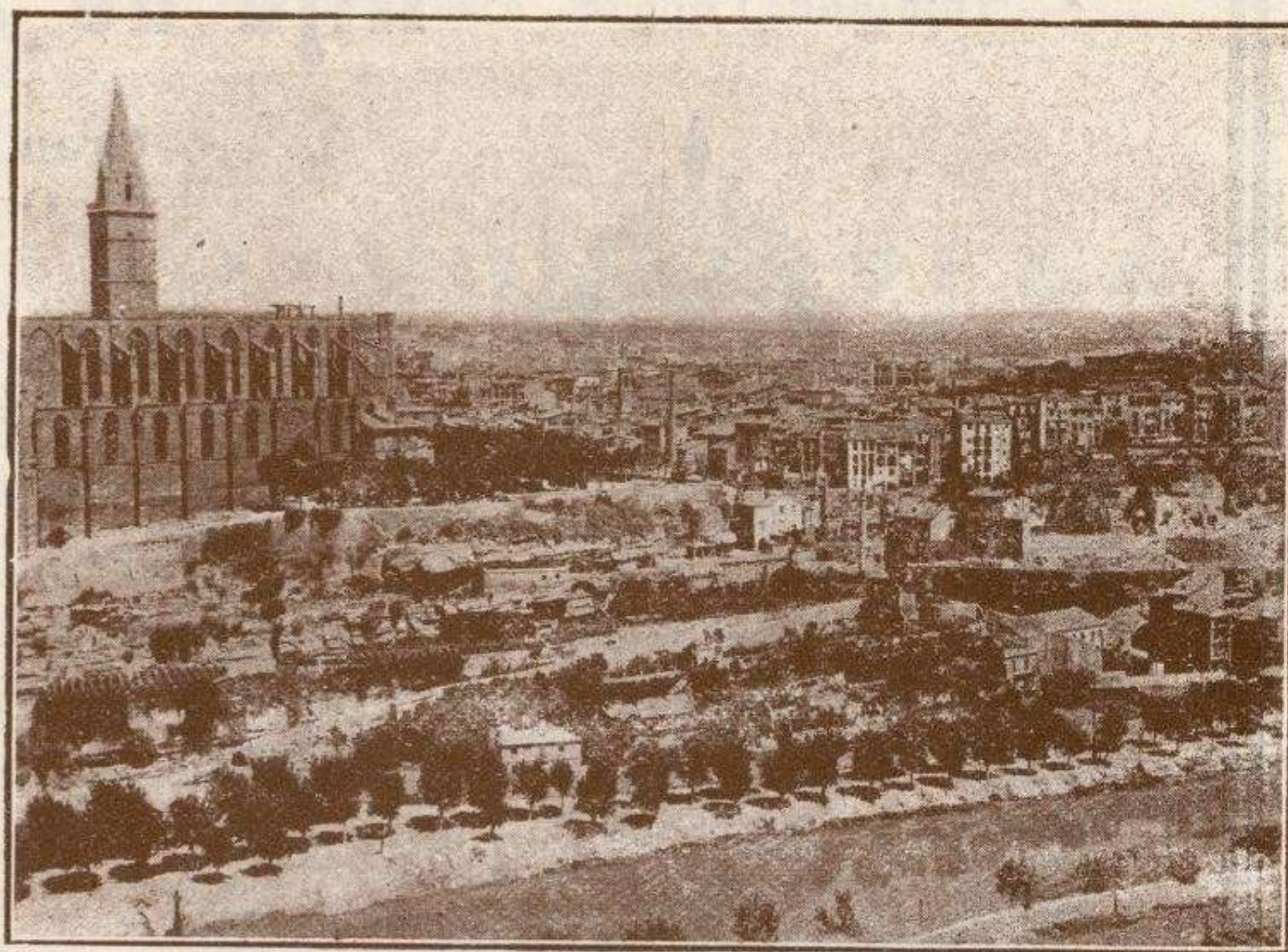
MANRESA.—Vista parcial tomada desde la carretera de "Can Massana"
