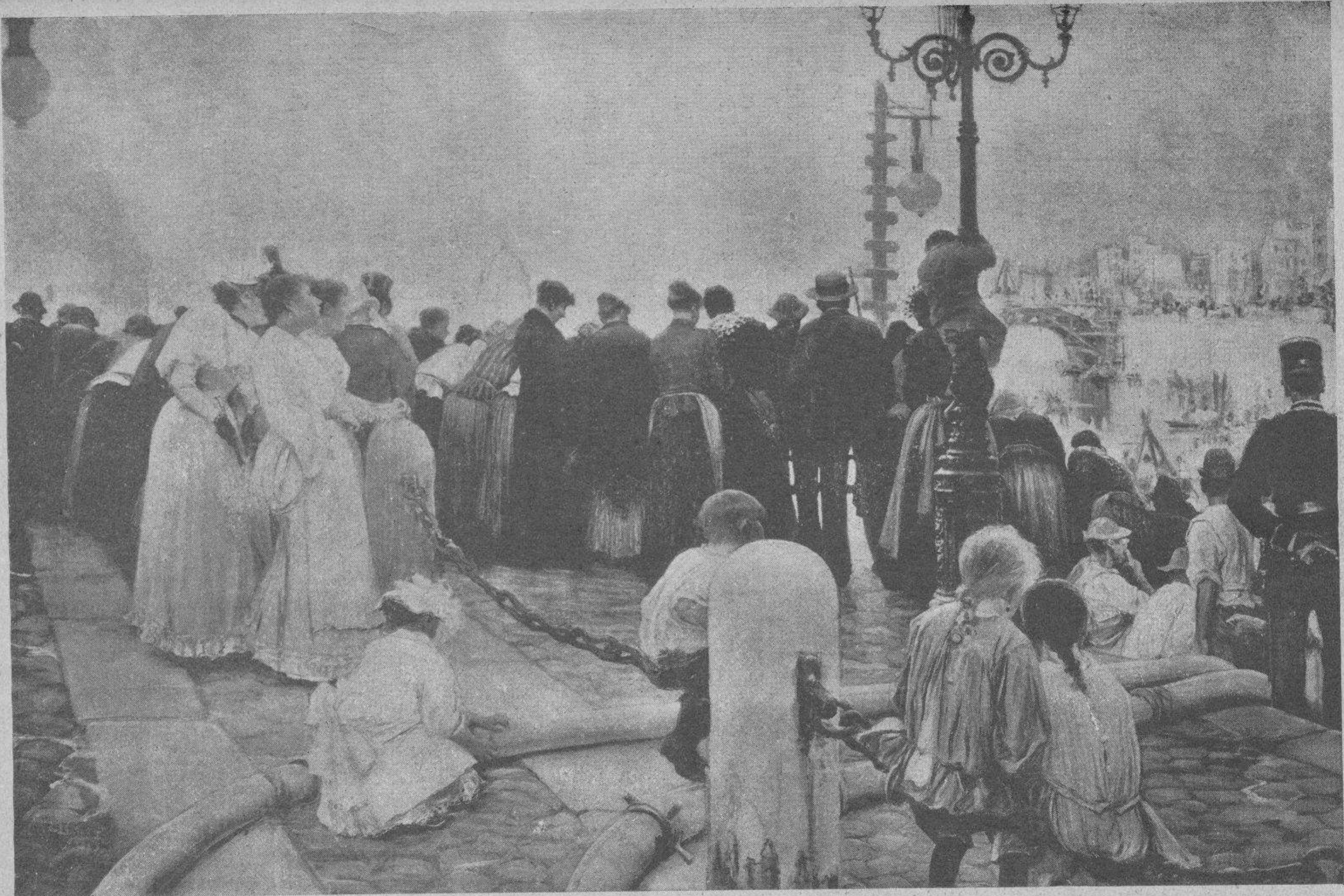
Trabajos en el Tiber.
