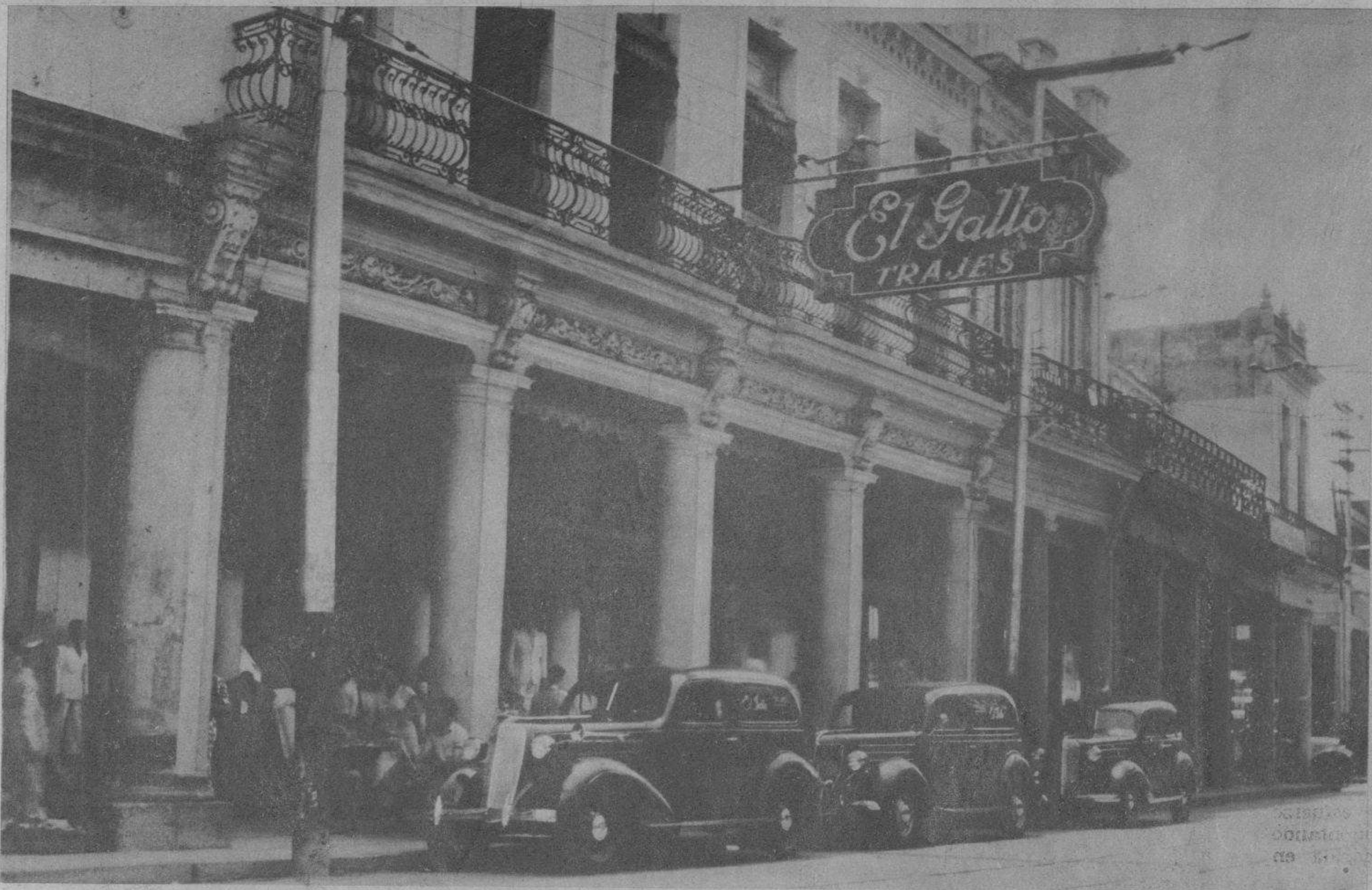
CASA CENTRAL, en Monte 205, 207 y 209, donde radican los talleres y oficinas generales de la organización
