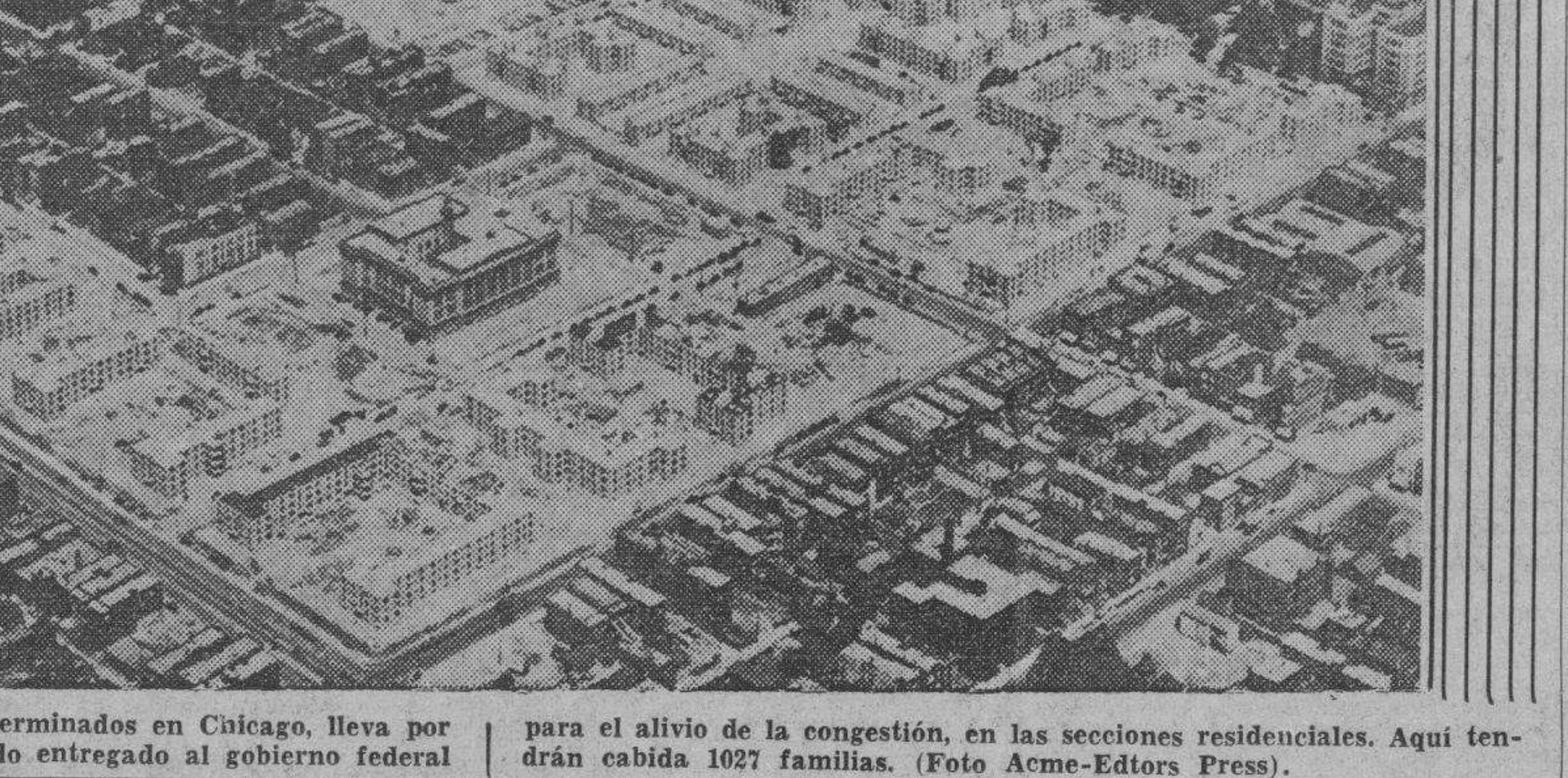
Este grupo de edificios recientemente terminados en Chicago, lleva por nombre «Jane Adams Houses» y ha sido entregado al gobierno federal para el alivio de la congestión, en las secciones residenciales. Aquí tendrán cabida 1027 familias. (Foto Acme-Editors Press).
