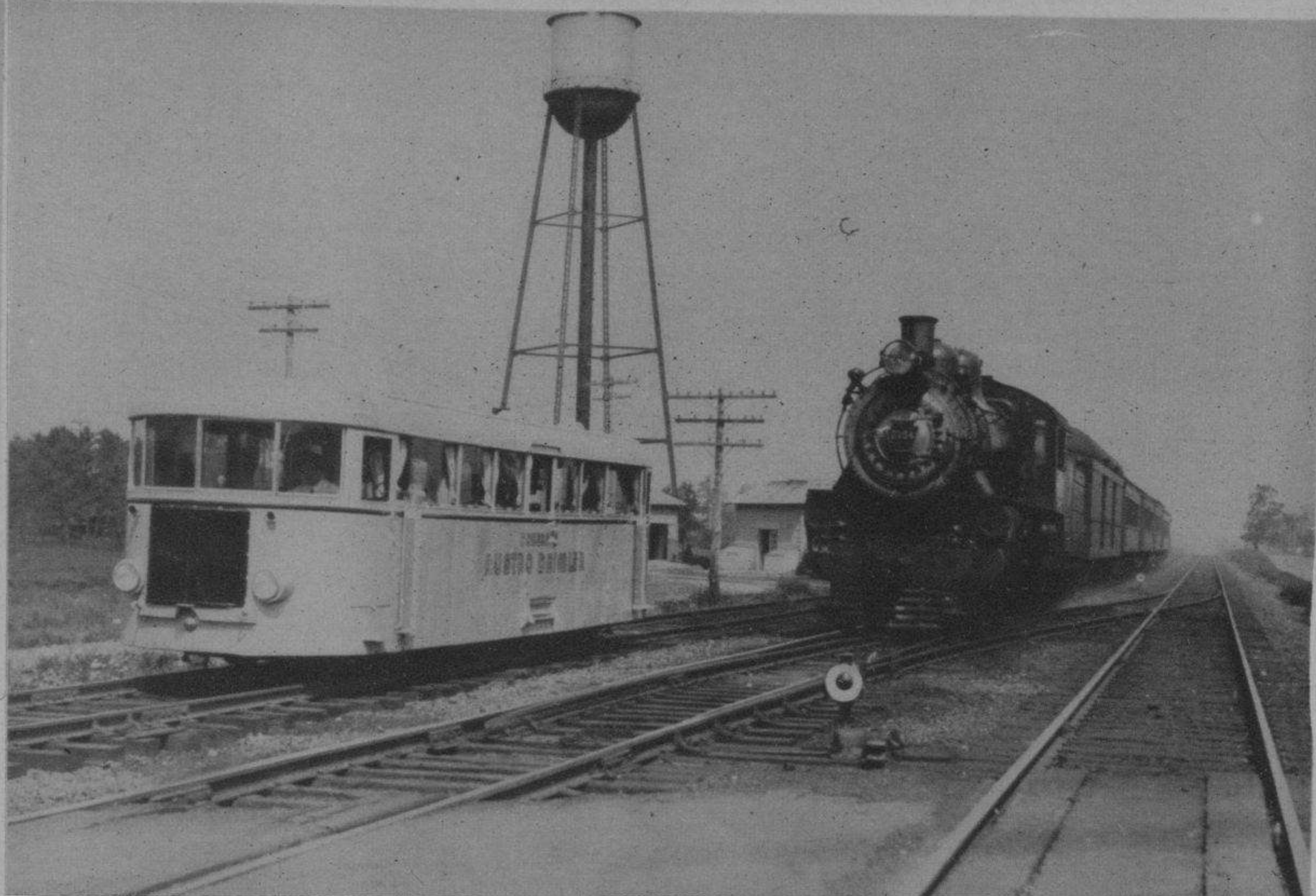
EL TRANVIA más veloz. En días pasados se celebró en Babylong, Long Island, la primera prueba de un nuevo tranvía construido por la firma Austro-Daimler, que sólo pesa 20.000 libras, provisto de un motor de gasolina de 80 caballos, que consume 7 galones de gasolina por milla y tiene asiento para 42 pasajeros. La velocidad que desarrolla es de 90 millas por hora.
