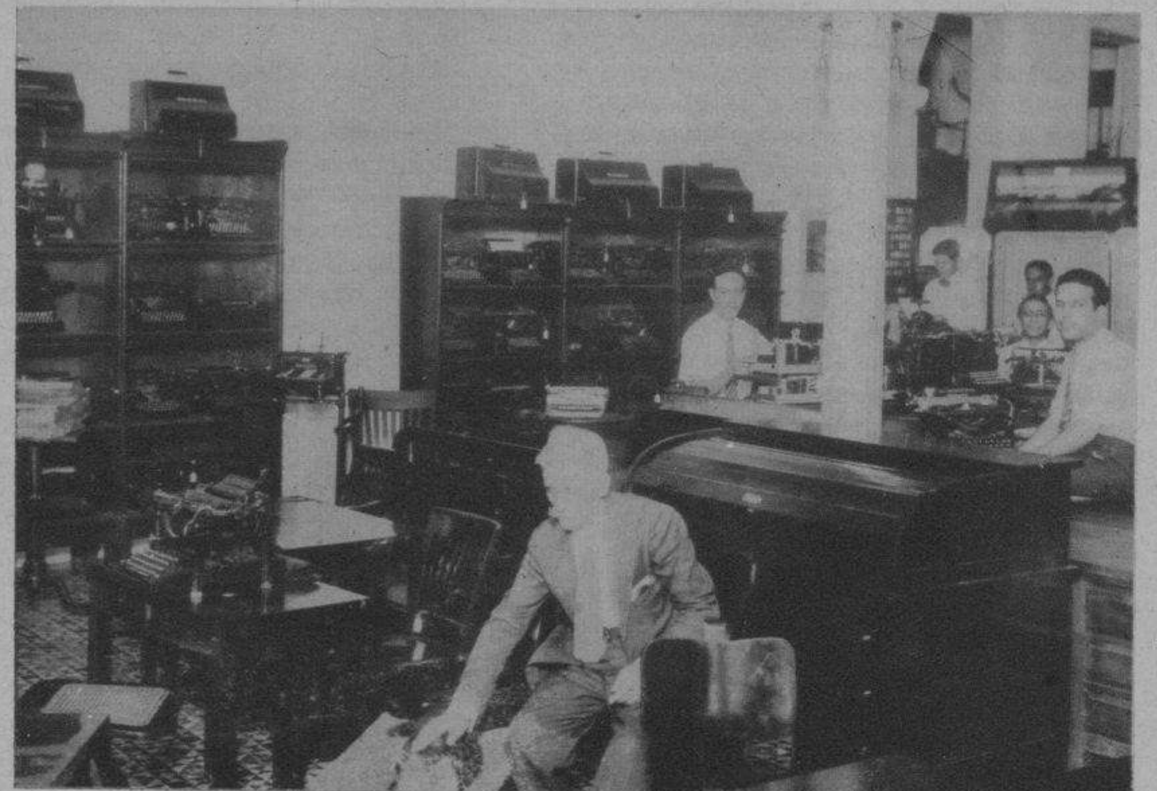
Interior del Dpto. de Máquinas.
