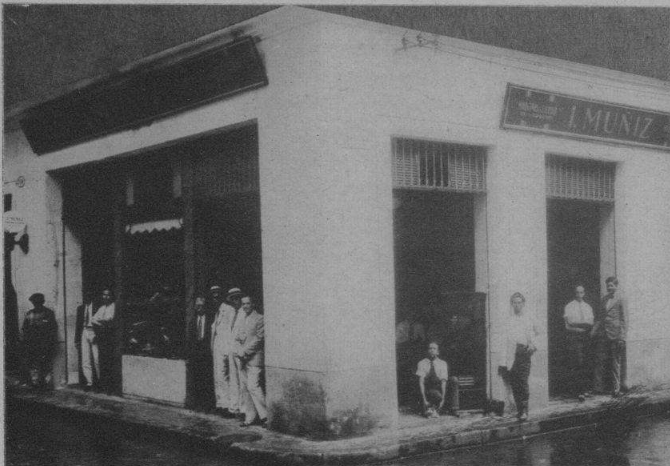
Fachada; Habana esquina Lamparilla.
