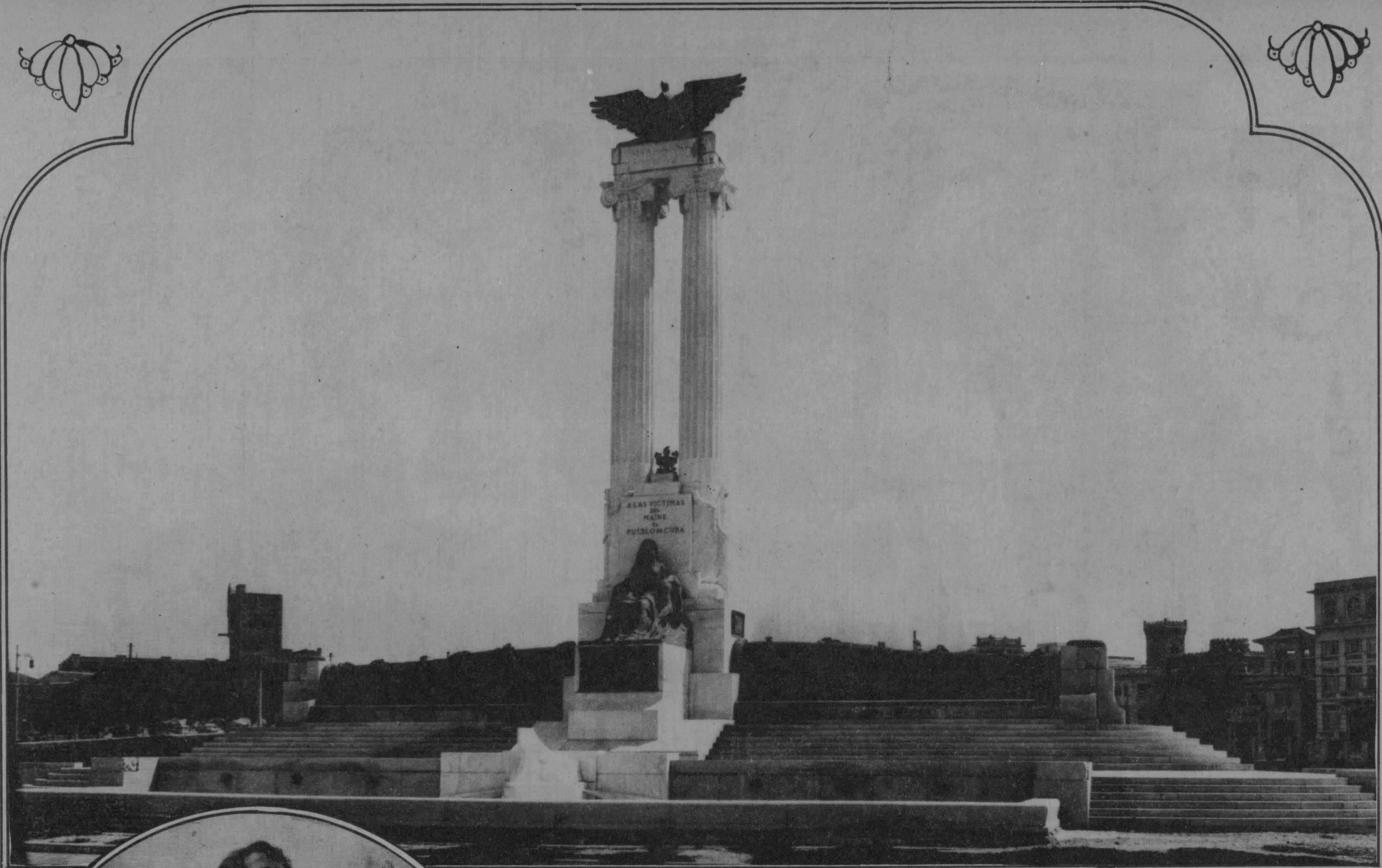
El monumento del «Maine», cuyas columnas fueron derribadas por el último ciclón, ha quedado restaurado de nuevo en la misma forma que fué ejecutado
