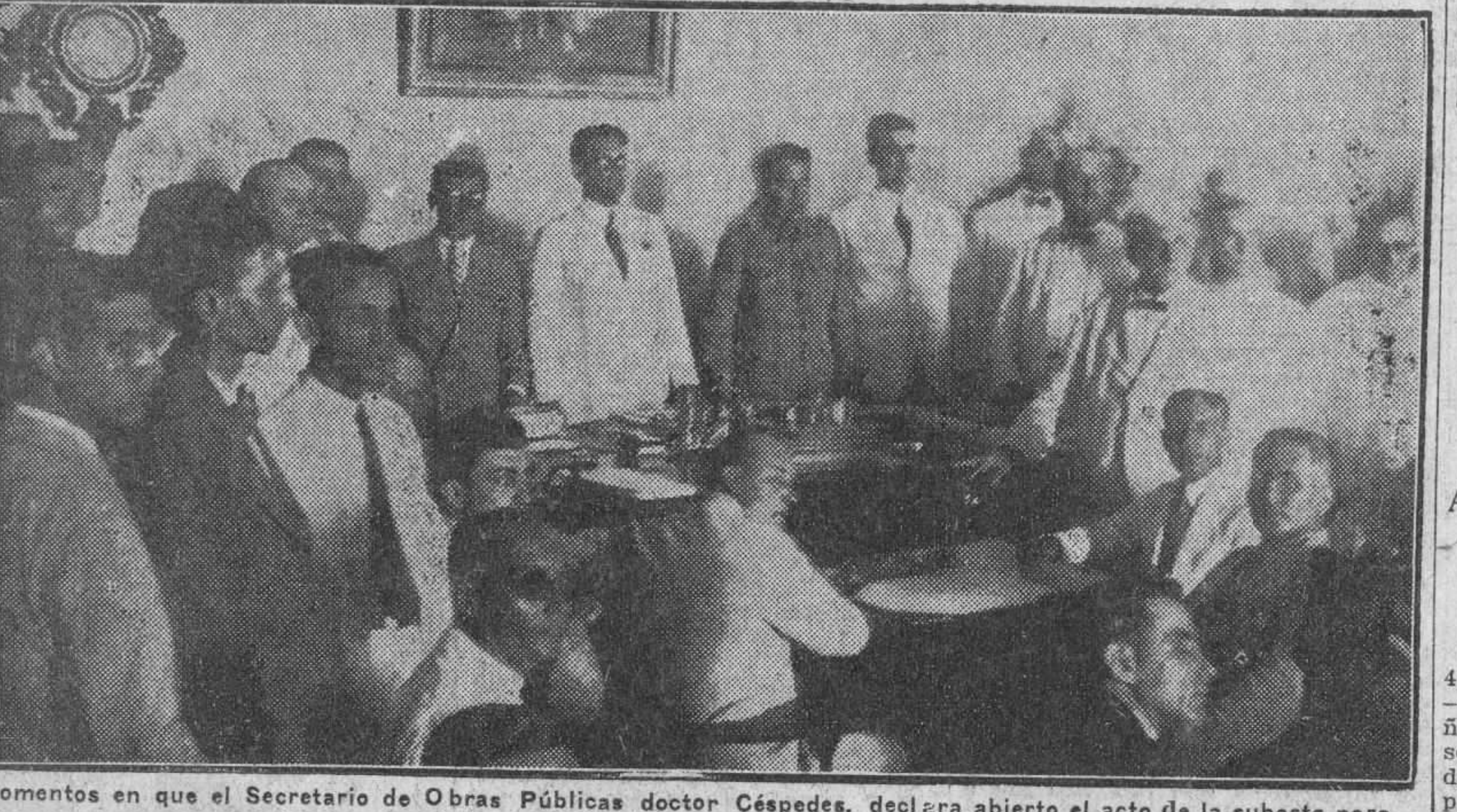
Momentos en que el Secretario de Obras Públicas doctor Céspedes, declara abierto el acto de la subasta para el acueducto de la capital occidental
