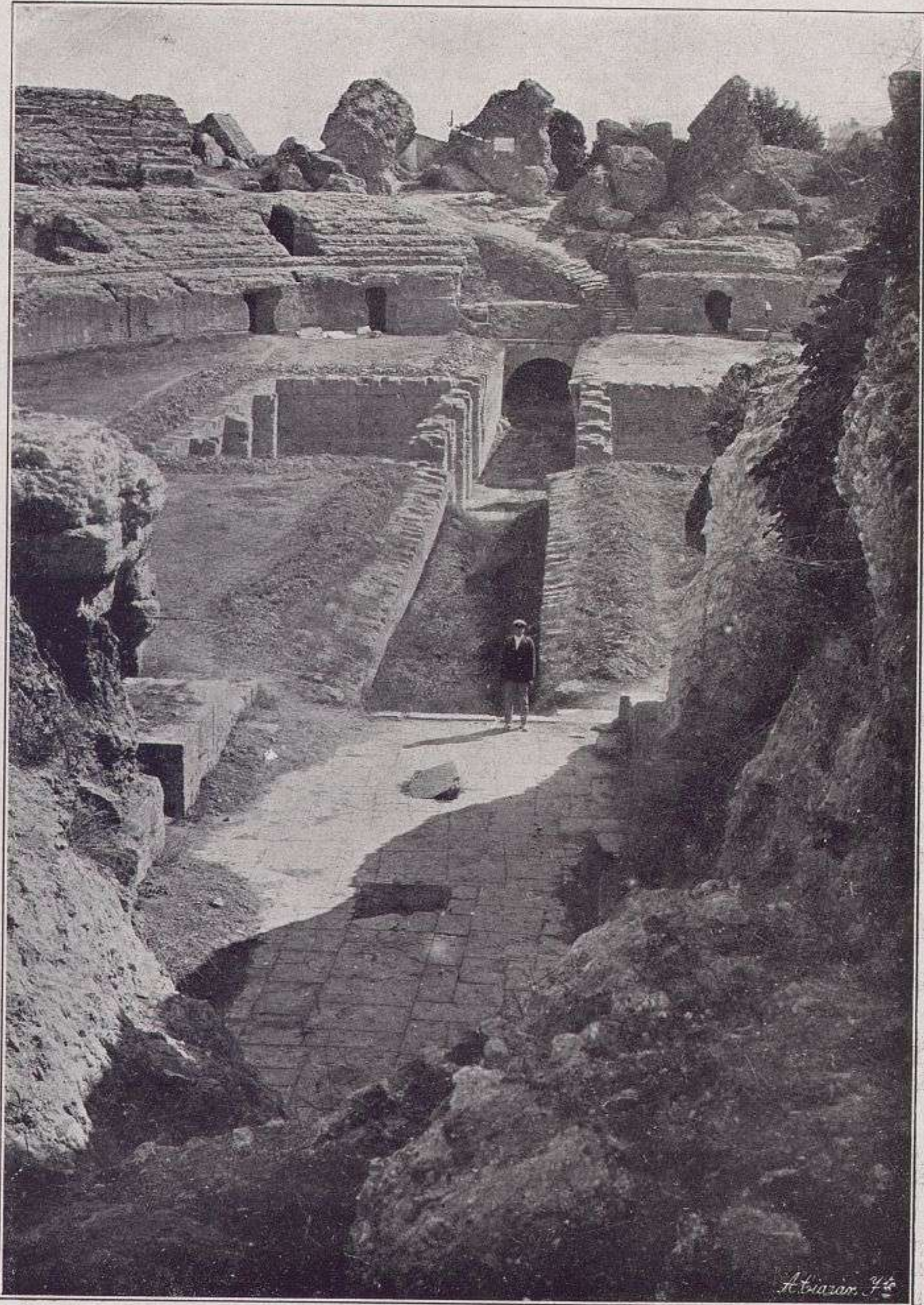
LA AVENIDA DEL EJE DE PONIENTE Y SU PAVIMENTO, VISTOS DESDE LOS ALTOS DE LA BÓVEDA CAÍDA, Y PRACTICABLE EN 1915
