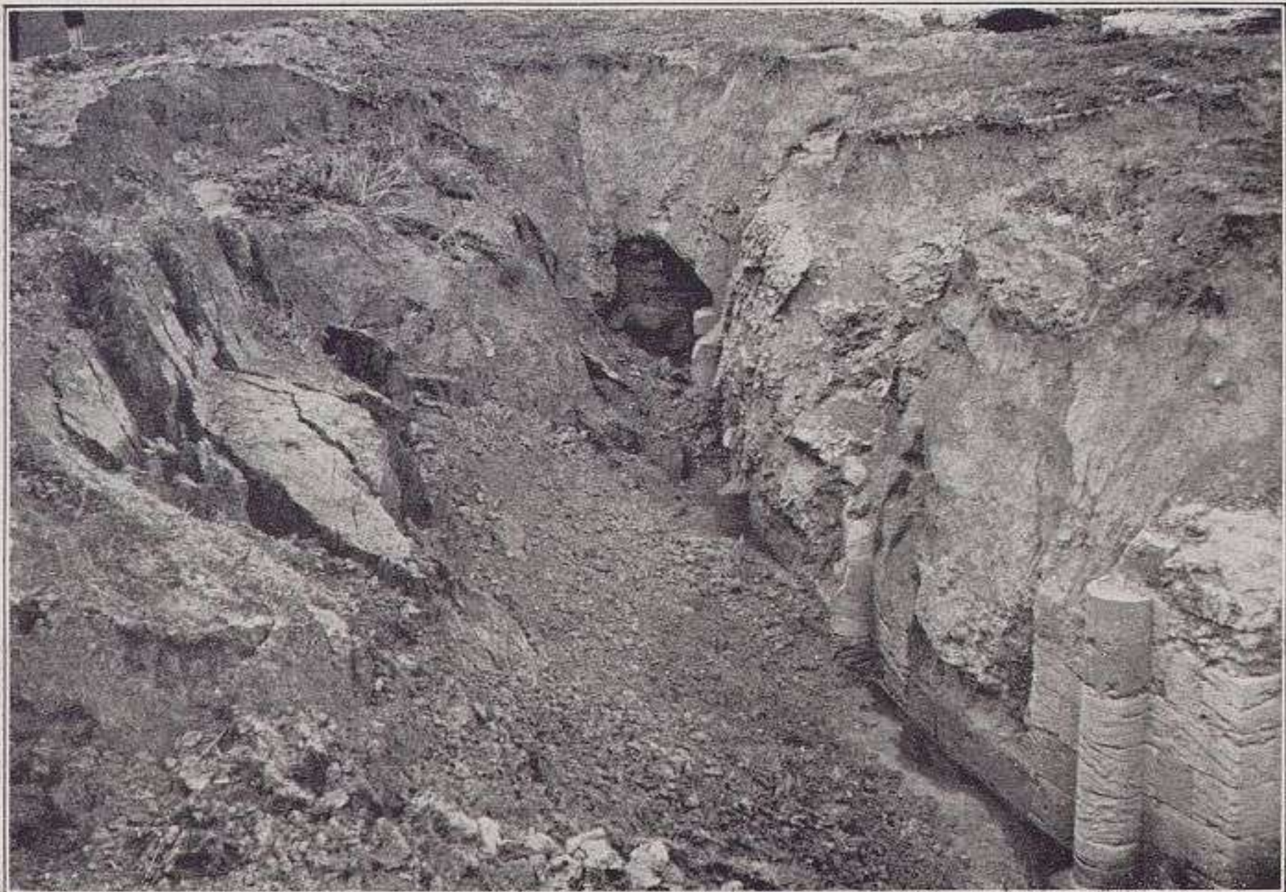
EL MISMO, DESPUÉS DE LA INVASIÓN DE LAS AGUAS
