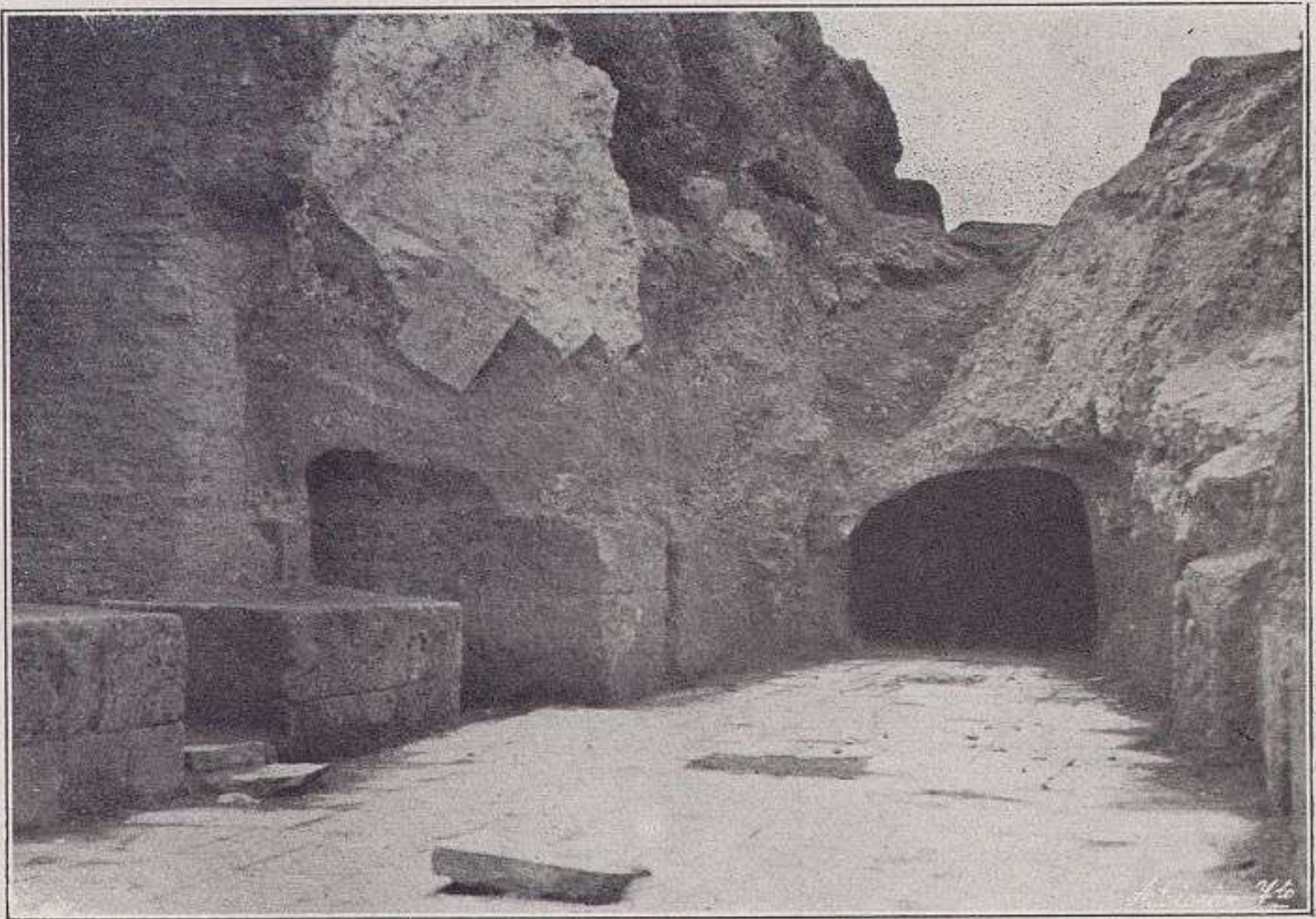
LA AVENIDA CENTRAL DEL EJE DE PONIENTE, AL TERMINAR EN 1914 LAS EXCAVACIONES, VISTA DESDE LA ARENA
