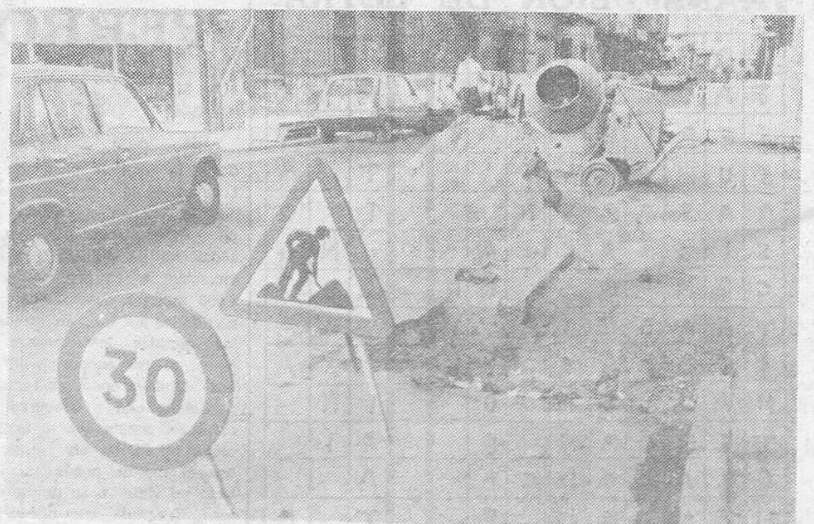
Las obras de embalsado de la calle de San Pablo se prolongan. Son quizás más complicadas de lo que podía esperarse, al menos, eso es lo que se pregunta el ciudadano de a pie. Con el ensanchamiento de la acera, la calzada ha quedado muy estrecha y, más aún con los obstáculos que se presentan al automovilista con las vallas por un lado y con los aparcamientos por otro. Esta situación no creemos que pueda durar mucho tiempo. — (Foto VILAFRANCA).
