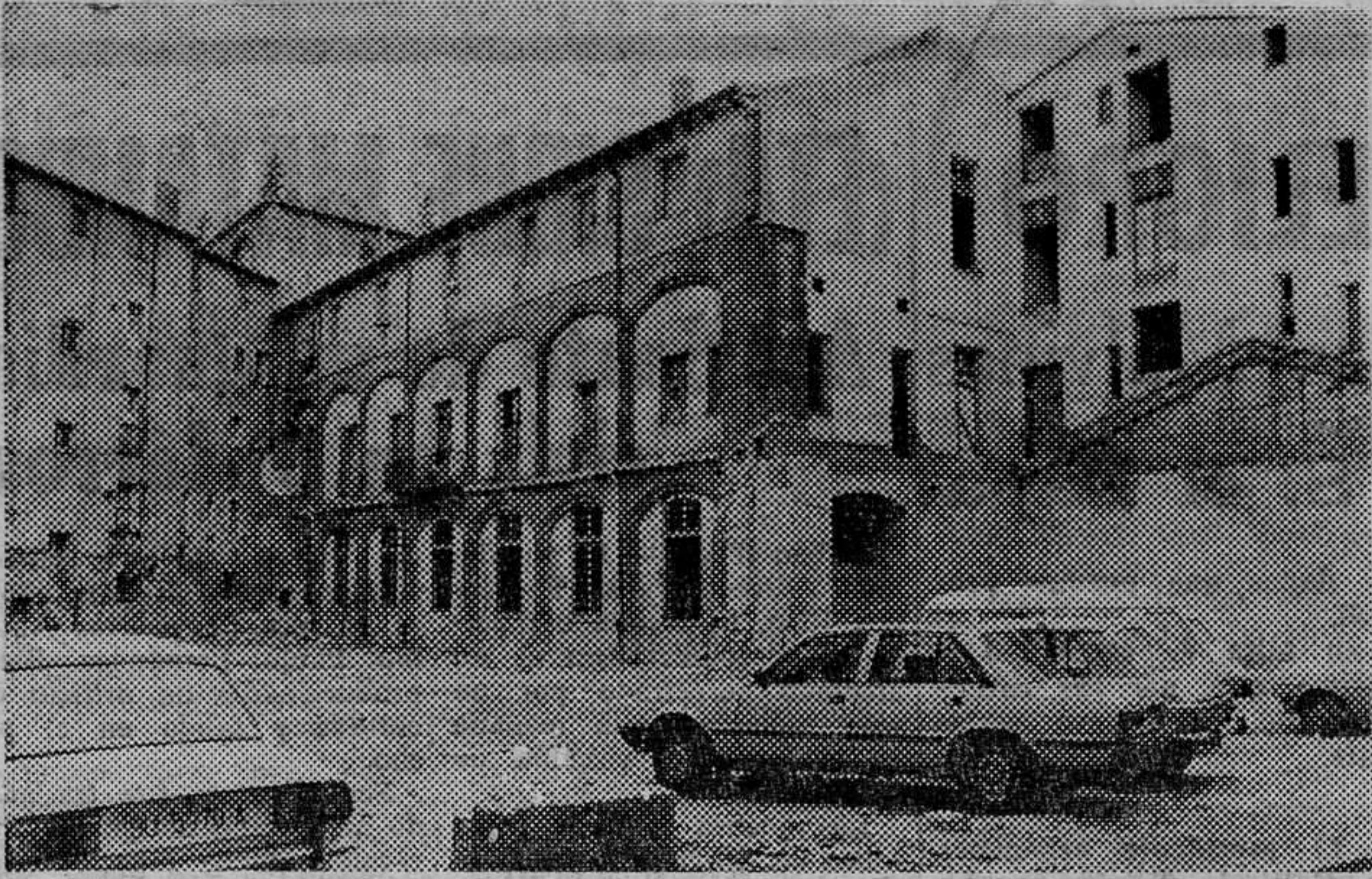
Esta es una vista inédita de una parte del Palacio de la Casa del Cordón, Joya del Renacimiento burgalés. Las obras que se llevan a cabo tratan de aislar totalmente el inmueble en varias fases y después habilitarlo para sede central de la entidad de ahorro propietaria, la Caja de Ahorros Municipal. Así ha quedado la parte de patios interiores, vista desde la calle del Cordón.
