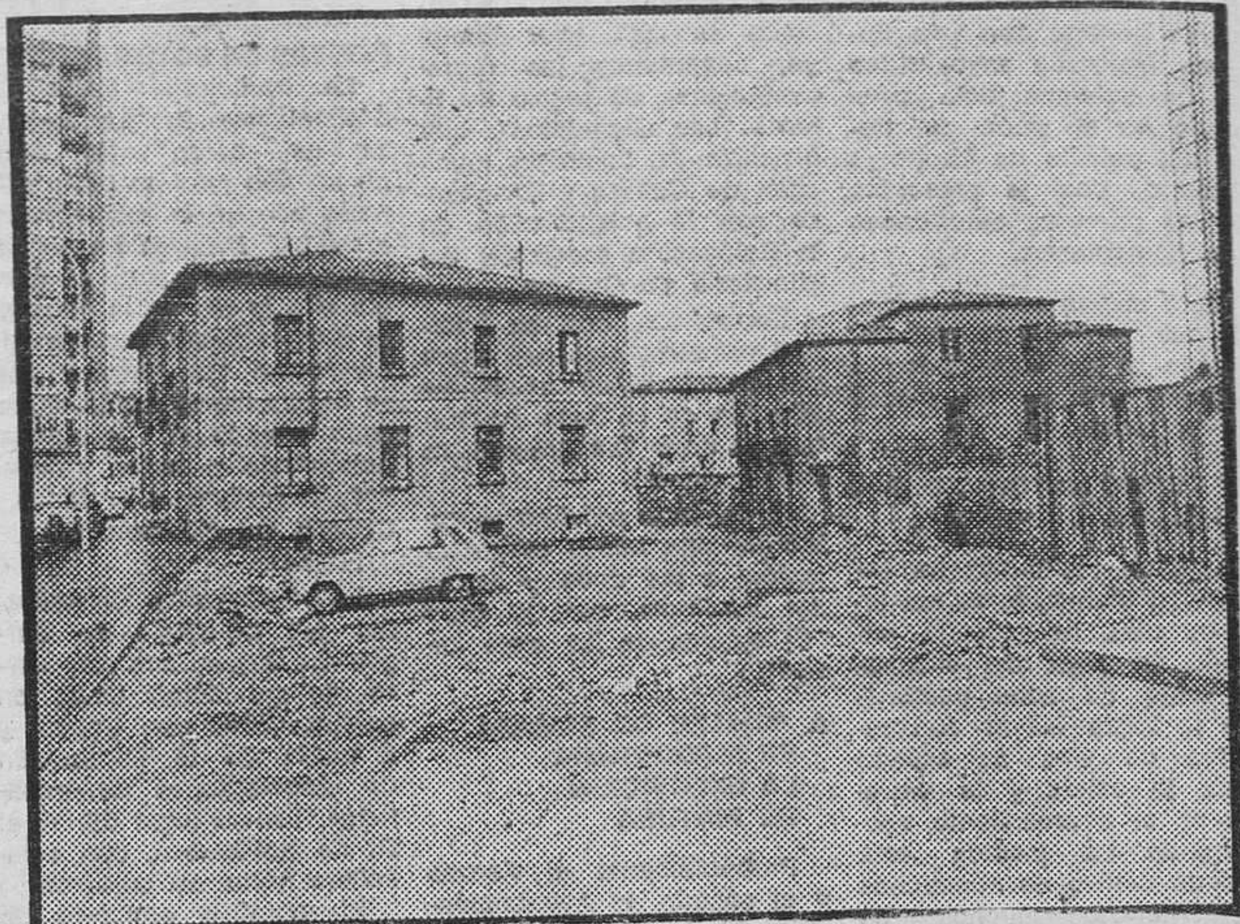
Aquí, dos viejos edificios que podrían tener un destino de gran utilidad práctica para toda esa amplia zona que se enmarca entre Francisco Grandmontagne y San Pablo. (Foto FEDE)
