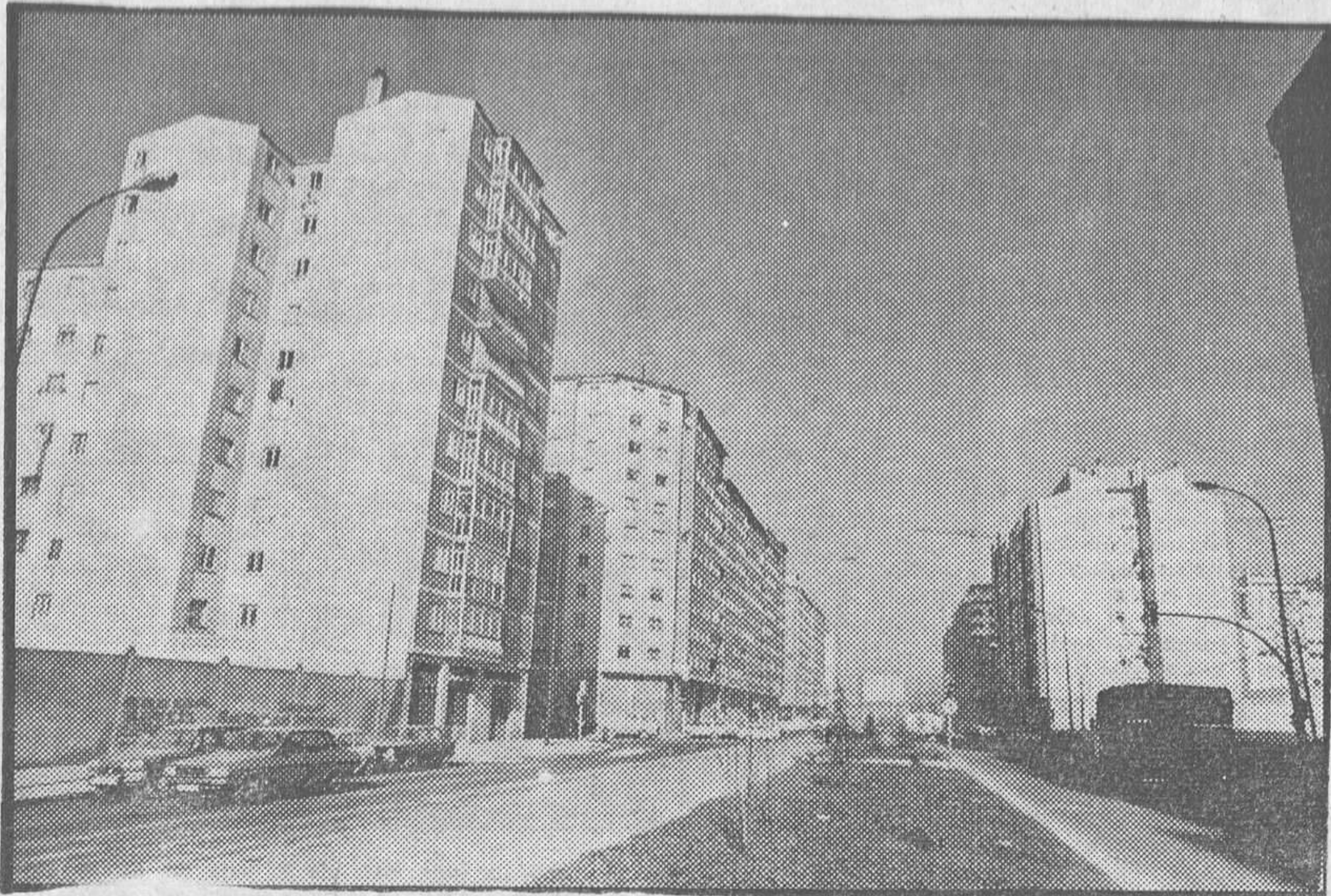
La avenida Eladio Perlado, una de las vías públicas comprendidas en el polígono G-9, constituye la principal arteria de comunicación entre los barrios de Gamonal y Capiscot y desde que entró en servicio viene cumpliendo una magnífica función, susceptible de perfeccionarse dentro de los nuevos núcleos vecinales de una ciudad en constante crecimiento.
