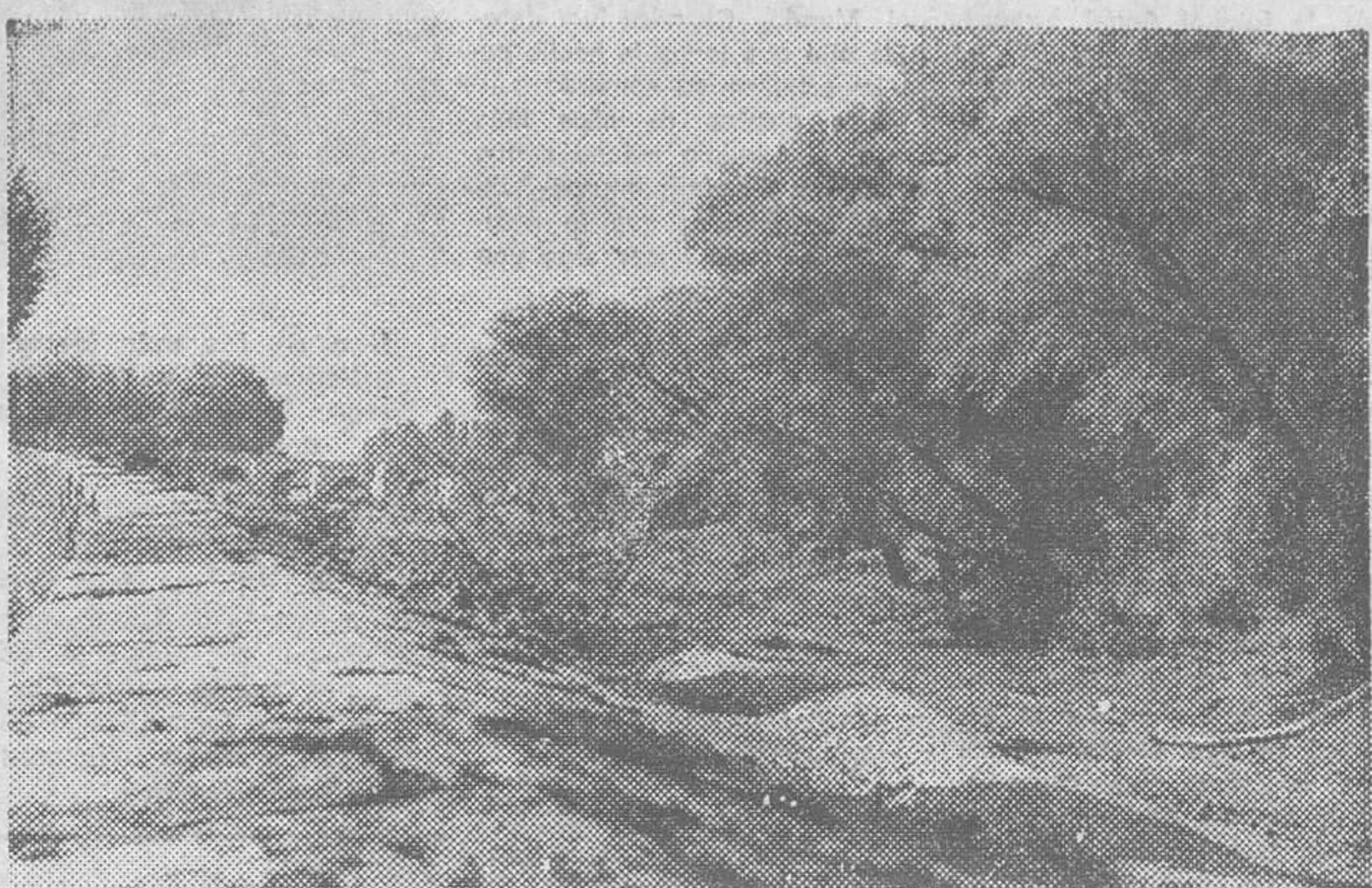
Desde la carretera de Valladolid, aguas abajo de los Arcos de Castilfalé, hasta el Puente de Malatos, todavía se conserva la masa arbórea reflejándose en el río. Exigencias de muro de contención, va a deteriorar en parte esa galanadura natural. (Foto FEDE)
