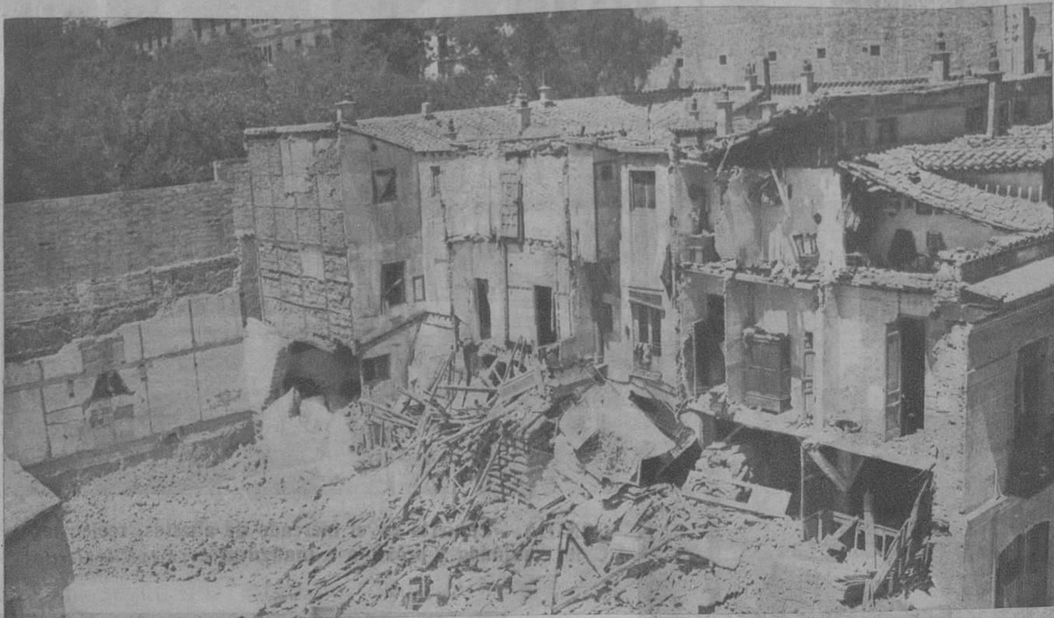
Estado en que quedó la casa de la calle de Fourquet, en Madrid, después de su derrumbamiento, en la madrugada del 19 de los corrientes. (Foto Marín)
