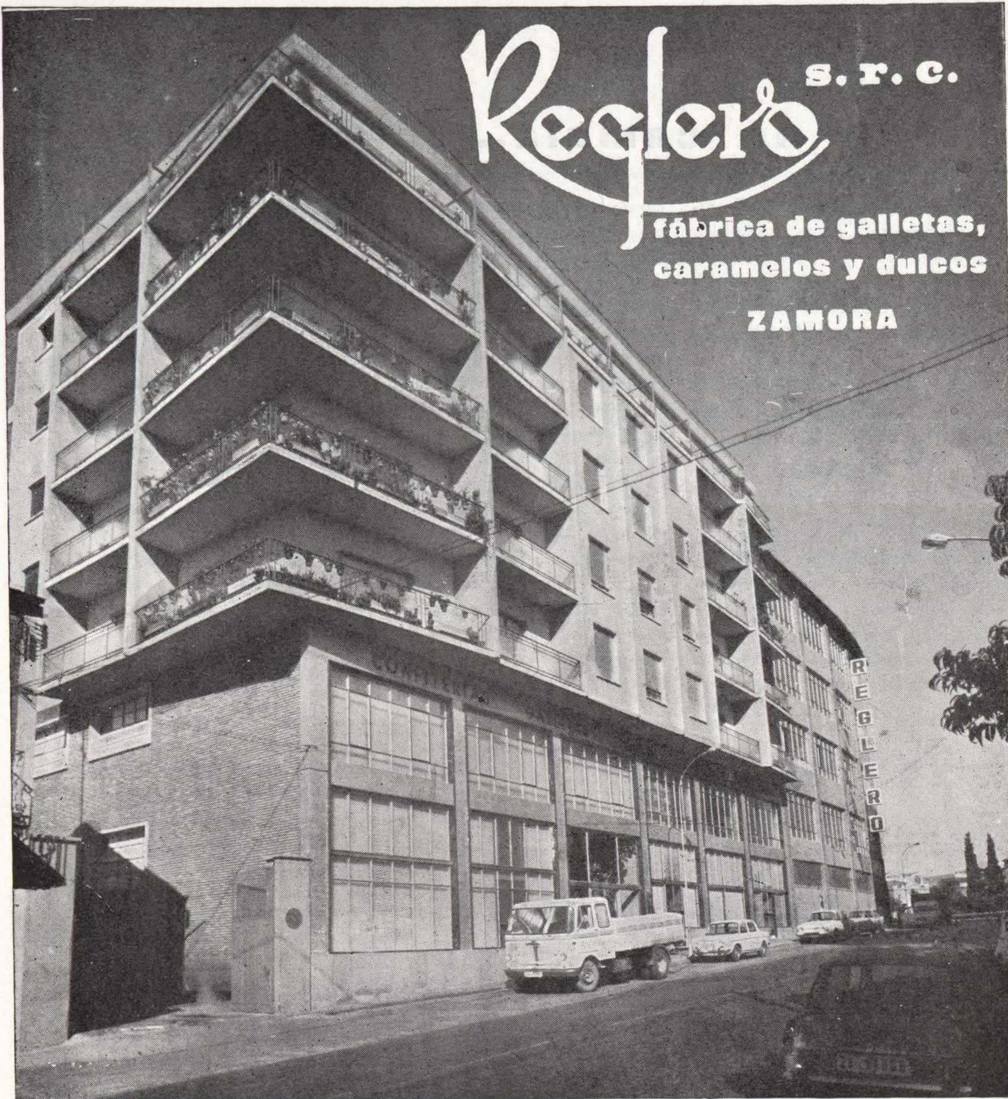
Fachada principal de la fábrica
